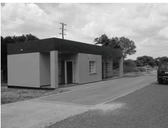
Mchinji: 旧ゲート付近に新設(EU 支援)された重量管理所と軸重計(22m タイプ)。オペレーションははまだ開始されていない。
