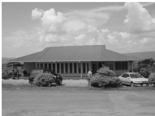
Mchinji: Mchinji 管理所は 2005 年に EU 支援により新設。新設にあたり旧管理所は 12km 国境側へ移動。
