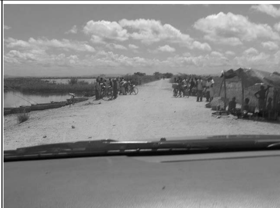
Bangla から Chiromo へ向かう道路、土堰堤。この先で流失している。渡し舟を待つ客で、賑わっている。
