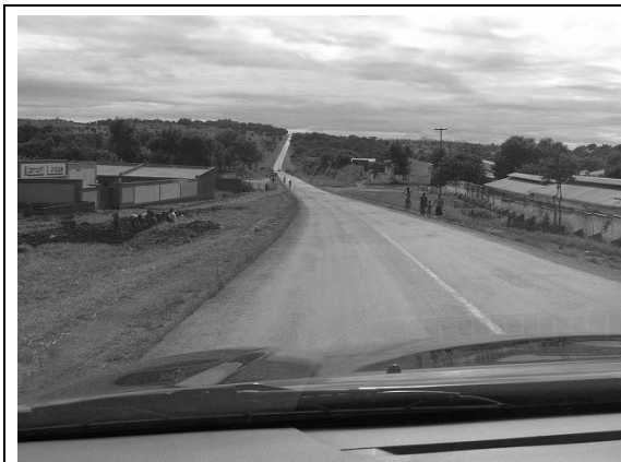
M-1 の状況 路面は良好である。
