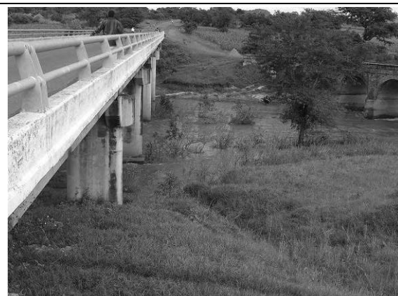
Nanjirt 川 (Lilongwe 川の支流) に掛かる橋右端に写っているアーチ橋は、旧橋。
