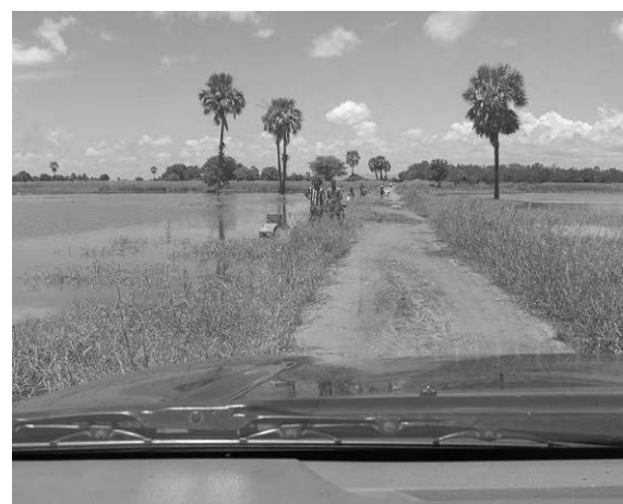
両側の水位が上がって水のなかを行く道。
