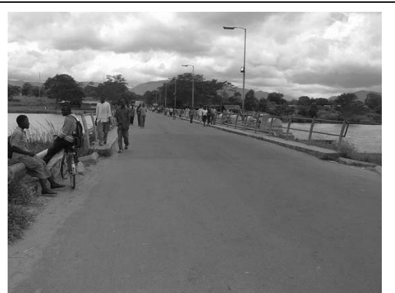
Liwonde の取水堰、上部は道路として使われている。
