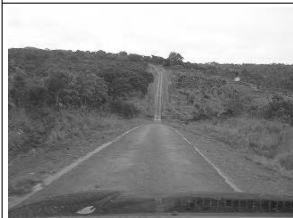
谷間越え (急勾配なのでこの間だけ、舗装。 最下部はコーズウェーとなっている)。
