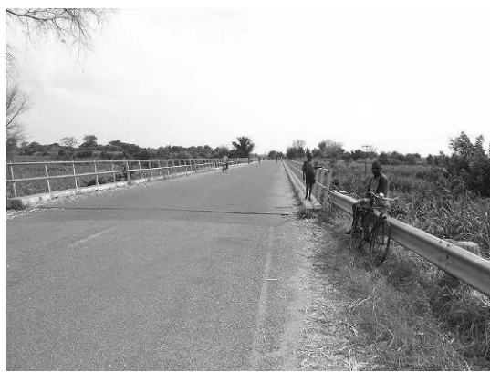
Linthipe 川橋梁 (Lilongwe 川もこの少し上流で合流) 既に 2 車線橋梁となっている。
