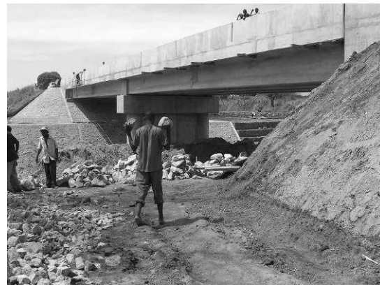
Luwandzi 橋梁 (完成間近) JICA 無償で架け替え工事を実施中。
