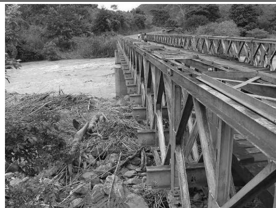
支間約 21m、3 径間のベイリー橋、川の水量も多く、濁流となっている。
