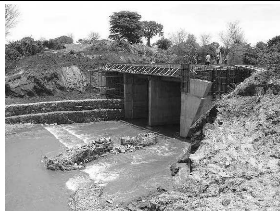
Nanyangu カルバート (設計は JICA、施工は NRA が直接現地業者に発注) 他橋に比べ少し遅れている。
