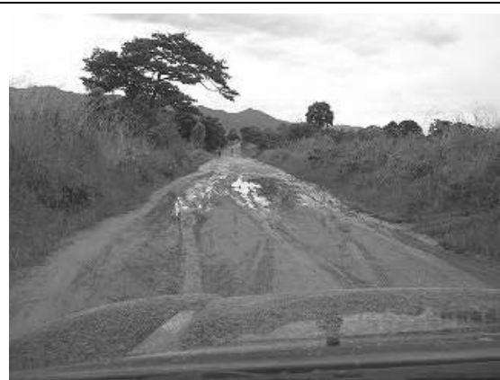
泥濘化した道路、この先も何箇所かあった。
