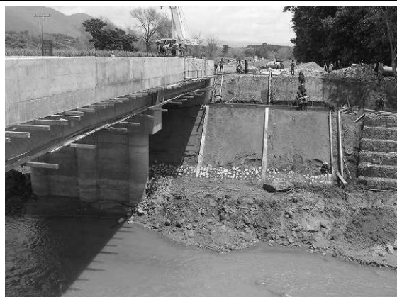
Nankokwe 橋梁 (護岸取付部を残すのみ) JICA 無償で工事中。
