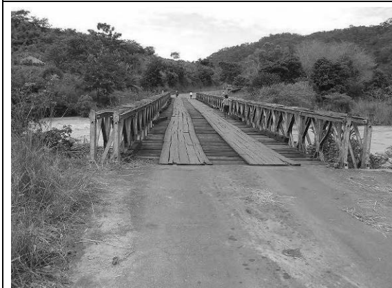
South Rukuru 橋(1 車線で、ベイリー橋が架けられている)。
