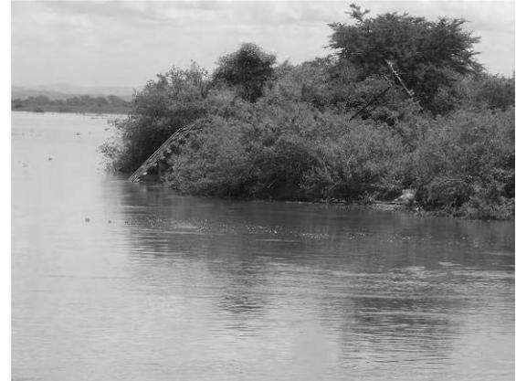
Chiromo の流失部: Bangla 側から見て、堤の左端に線路が水に洗われているのが見える。
