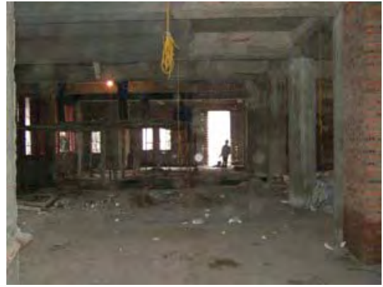
無償資金協力によるラボ設置予定の3階部分
