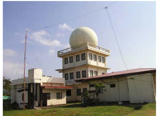
写真-2: 観測所の裏側外観
