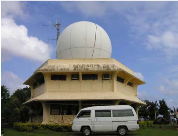
写真-1: 観測所の外観
