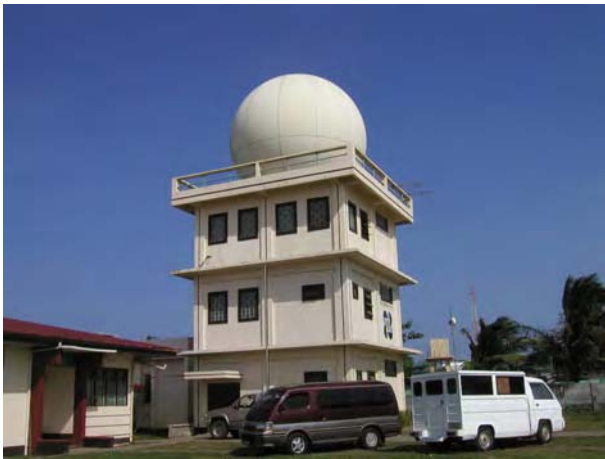
写真-1: 観測所の正面外観
