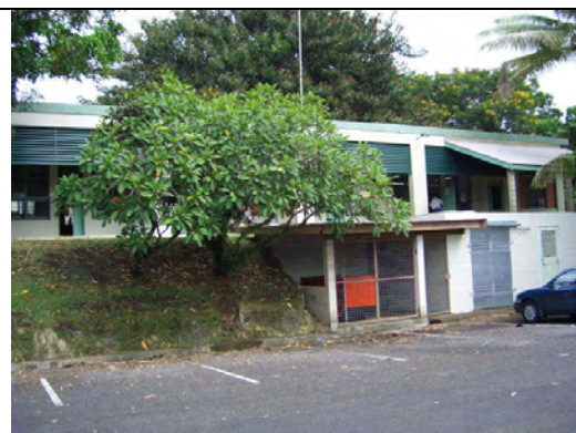
既存自家発電電気室・受電室
