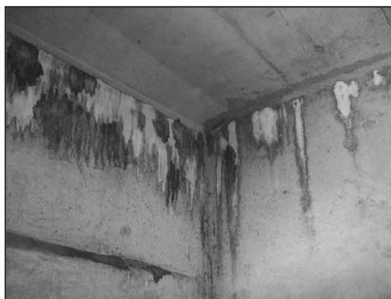
写真-2.2 上部工 横桁端部の状況（ファティマ橋）
