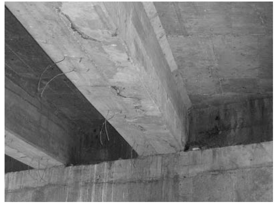
写真-4.2 コンクリート橋 主桁補強
