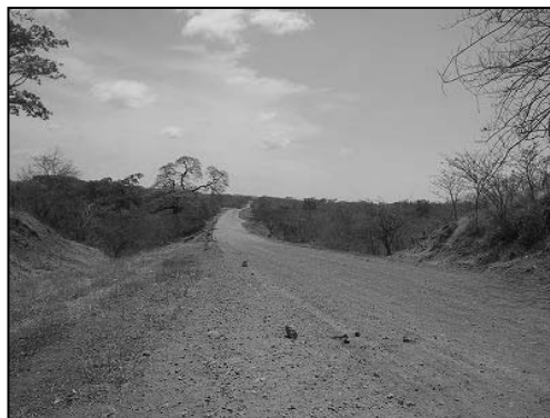
写真-2.13 道路状態
