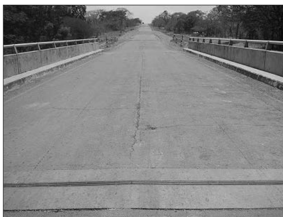
写真-2.1 路面舗装の状況（リオ・セコ橋）
