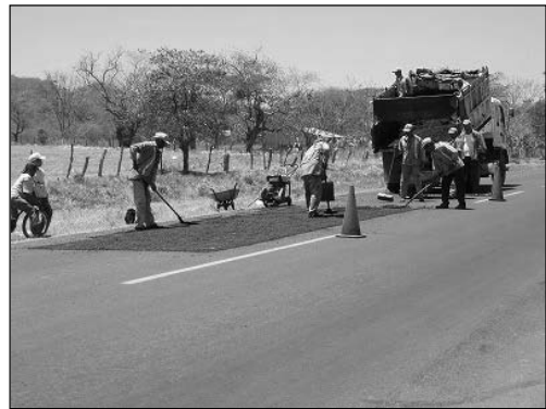
写真-2.3 道路補修状況
