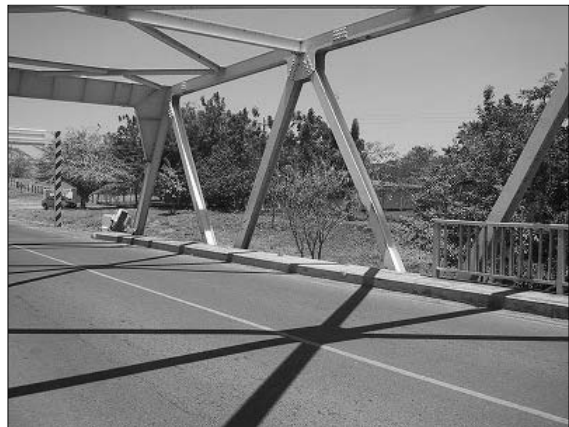
写真-2.4 高欄・親柱損傷部の状況 (ラス・ラハス橋)
