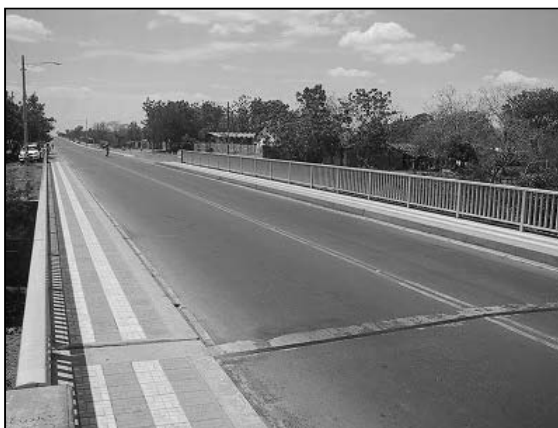
写真-2.13 橋面舗装の状況（ラス・マデラス橋）
