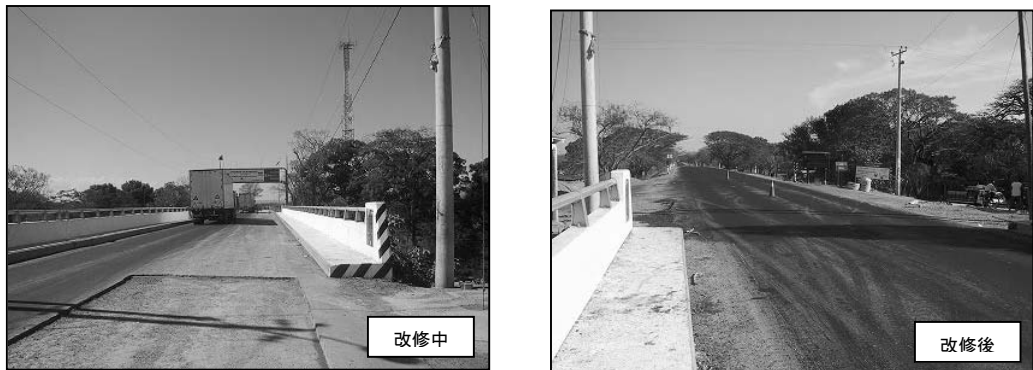
写真-2.6 取付け道路 舗装メンテナンスの状況（オチョモゴ橋）
