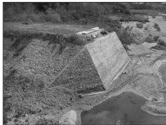
写真-2.8 橋梁下流部に残された盛土部分の状況（アト・グランデ橋）
