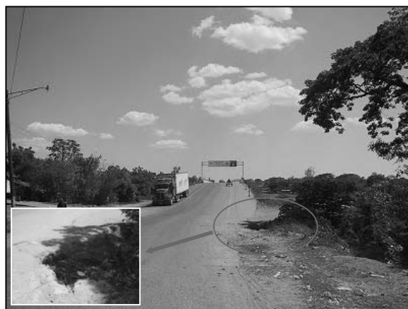
写真-2.11 取付け道路部の状況（エル・ガジョ橋）
