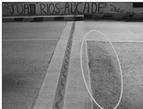
写真-2.9 伸縮装置背面の舗装状況（リオ・ネグロ橋）
