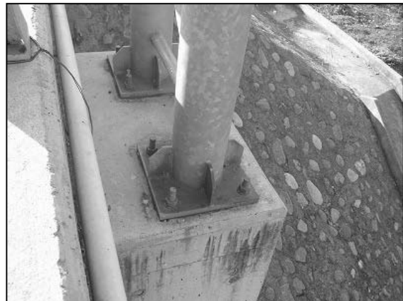
写真-2.7 ゲート式看板支柱取付け部の状況（エル・グアルモ橋）
