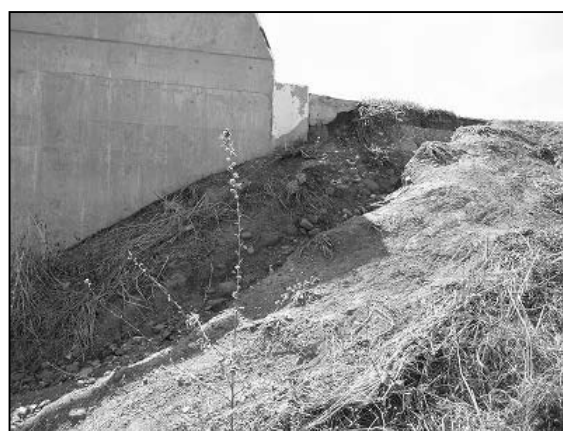
写真-2.10 ウィング取り合いの法面状況（リオ・ネグロ橋）
