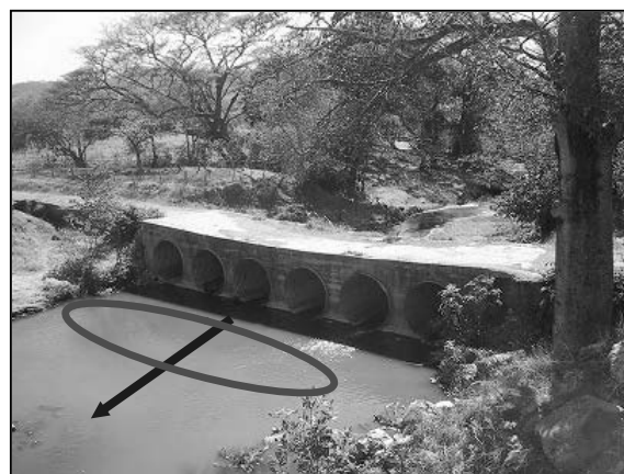
写真-2.5 仮設構造物の状況 (ヒル・ゴンザレス橋)
