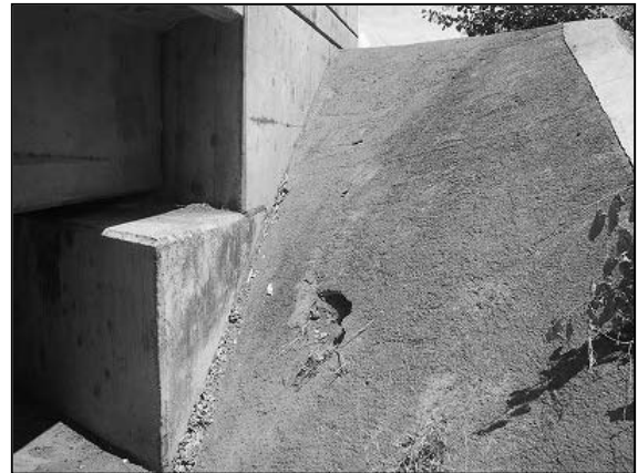
写真-2.3 橋台部 法面保護部の状況 (サン・ロレンソ橋)
