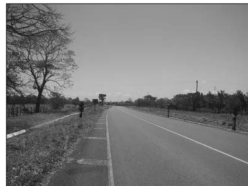
写真-2.5 道路状態（ラス・ラハス橋近傍）
