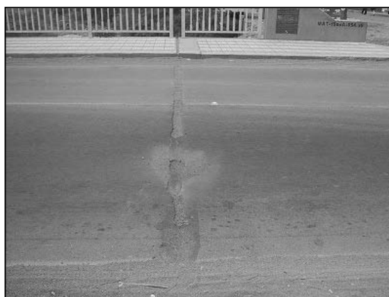
写真-2.14 オーバーレイによる舗装改修の状況（セバコ橋）
