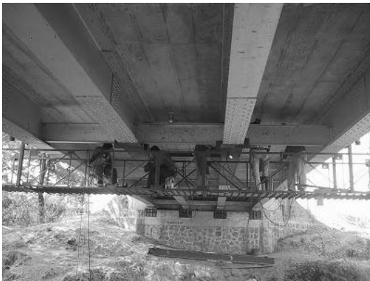
写真-4.1 鋼橋の主桁補強工事
