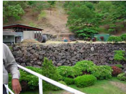
写真 17 発電所建屋増設スペース
