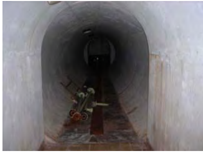
写真 14 連絡通路内部
