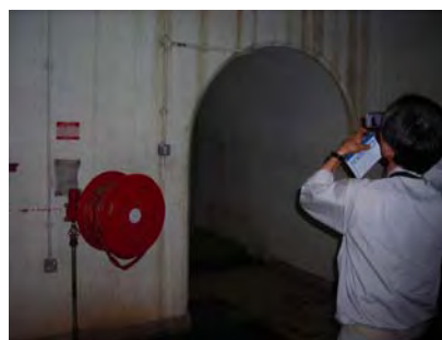
写真 13 増設箇所への連絡通路
