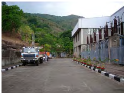
写真 18 既設発電所及び増設発電所方向
