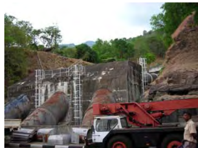
写真 19 既設水圧鉄管
