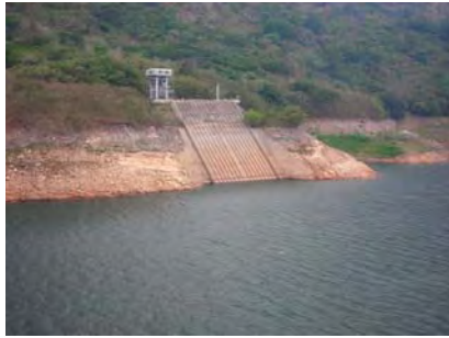
写真 5 発電所取水口全景
