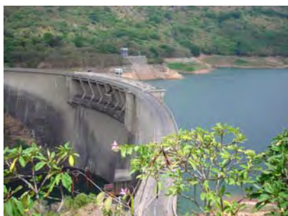
写真3 ダムと発電所取水口
