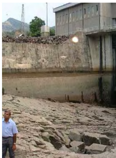
放水口状況 (CEB提供、2000年点検時撮影)
