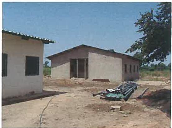
建設途中の入院病棟。この施設の後ろ側が新設サイト。手前は現在活動中の保健センター
