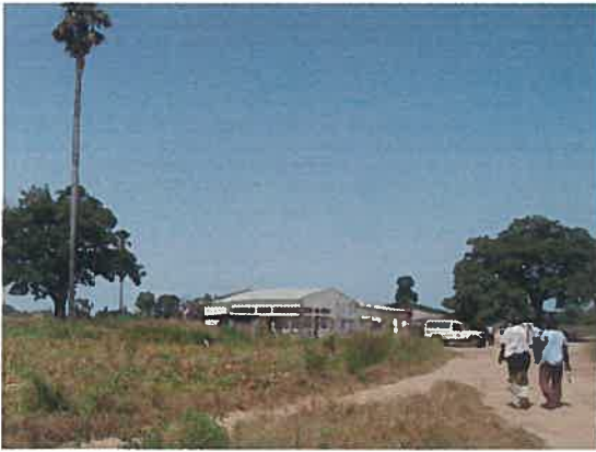
全景。手前から看護師宿舎、現在の保健センター、建設途中の入院病棟
