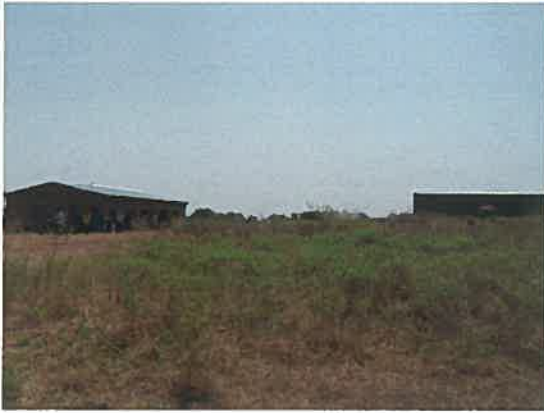
新設 PS の建設予定地。左が保健小屋、右は小学校
