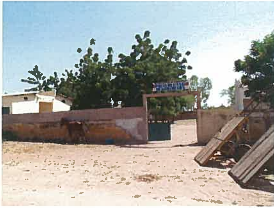
正面入口。左が診療施設、右が入院施設。診療施設の奥に看護師宿舎がある。
