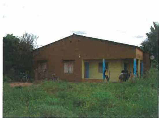
PS 右奥に小さな給水塔が見える
