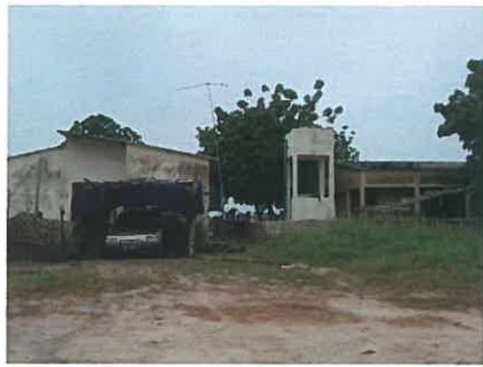
使用されていない廃墟
