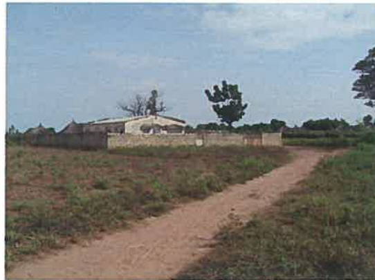
現在使用されていない保健小屋
