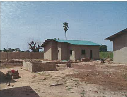
BID 資金により建設途中の医師（センター長）宿舎と入院病棟（右側）
