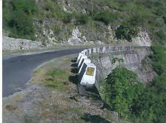
石積み土留擁壁の上に設けられたコンクリート製転落防止用パラペット。
