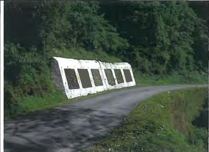
土砂崩れ防止用の石積み土留擁壁
