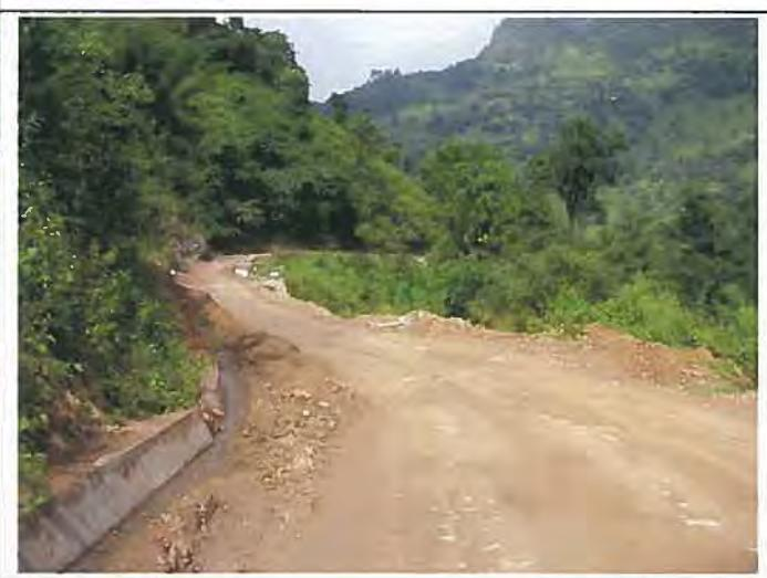
約 1km の軟弱地盤の区間は非舗装となっており、毎年雨期になると地盤沈下、土砂崩れが発生する。
