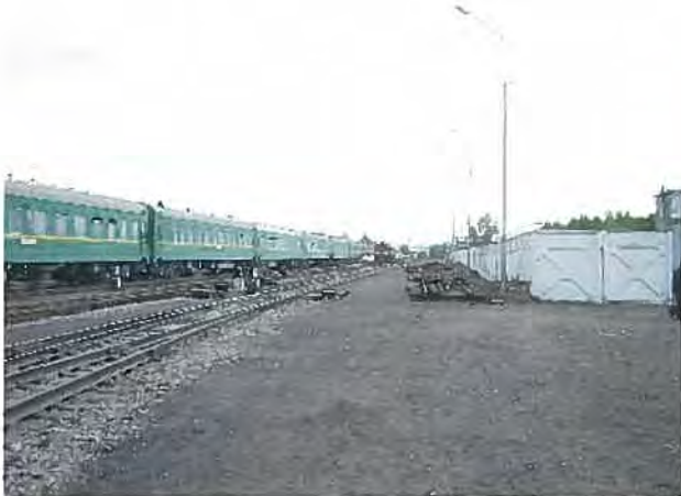
要請案：右側塀内は鉄道管理用地。照明灯は鉄道内の照明用。塀を取り壊して橋脚を施行する予定。
