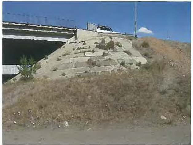
グルバルジン橋：橋台および橋台押さえ盛り土。
