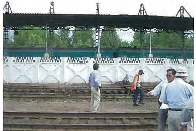
要請案：大統領専用列車プラットフォーム屋根。屋根を吊り支えている鋼材は撤去可能。この屋根を越えて架設する。
