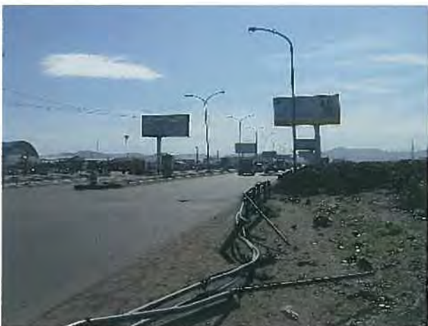
マーケット横：架橋候補位置より産業道路を撮影。鉄道と産業道路の間が狭く、ランプの曲率半径は小さくなる。
