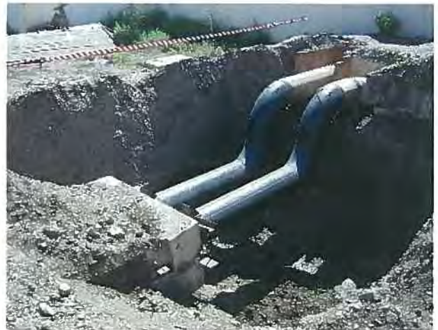
埋設物：コンチネンタルホテル近くでの暖房用 D=400mm管敷設工事写真。掘削深さ2～3m。
