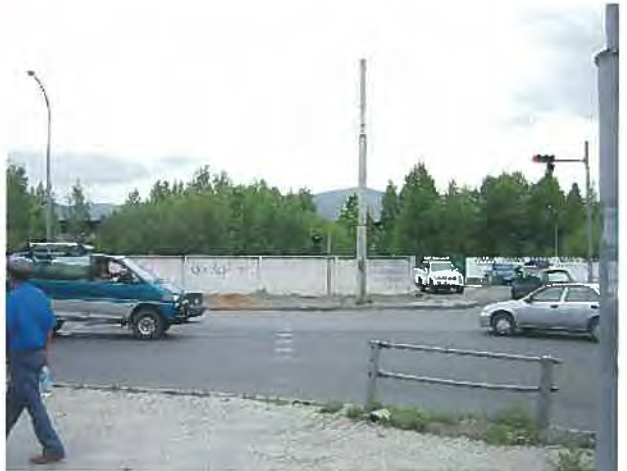
要請案：産業道路交差点北側より撮影。正面の林は大統領専用列車ホーム前広場。左側塀の向こう側に橋脚施行予定。
