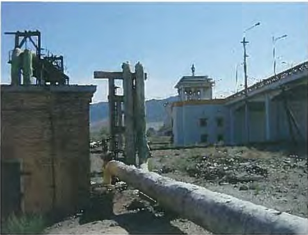
平和橋：東側に暖房用パイプが敷設されている。西側にはビルが建設されている。
