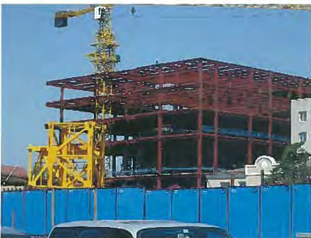
ビル建設：鉄骨構造。鉄骨の加工は出来るが、鋼橋の 製作の経験は無い。
