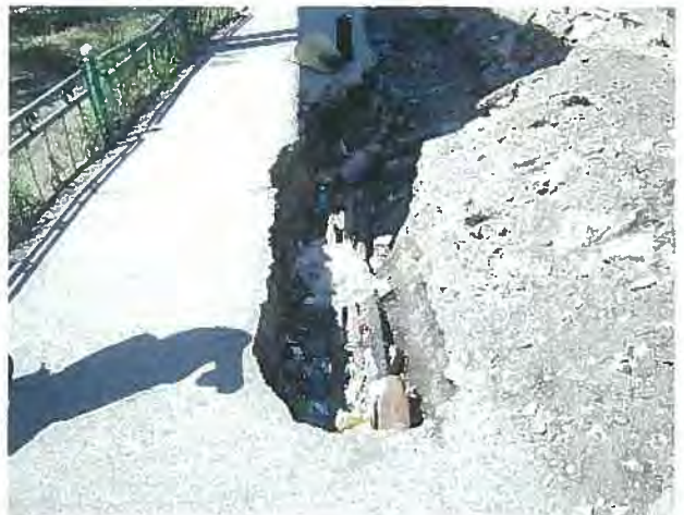
埋設物：平和通り歩道部における電気ケーブル敷設工 事写真。
