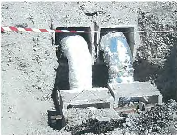
埋設物：コンチネンタルホテル近くでの暖房用 D=400mm管敷設工事写真。断熱材を巻いている。
