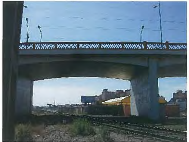
平和橋：鉄道を跨いでいる。
