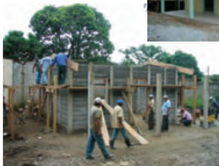
耐震普及モデル住宅を施工する施工技術研修員
