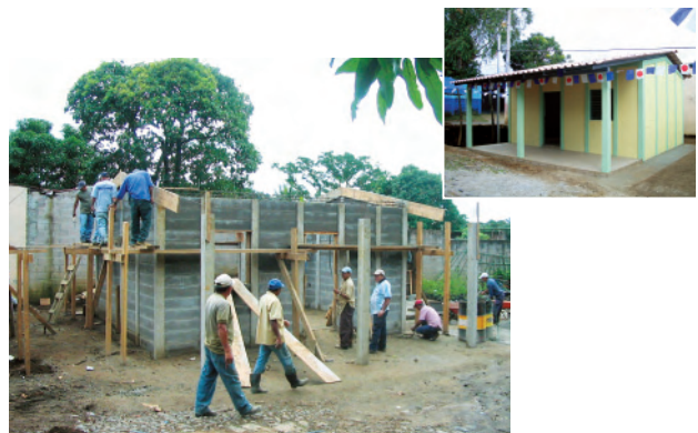
耐震普及モデル住宅を施工する施工技術研修員
