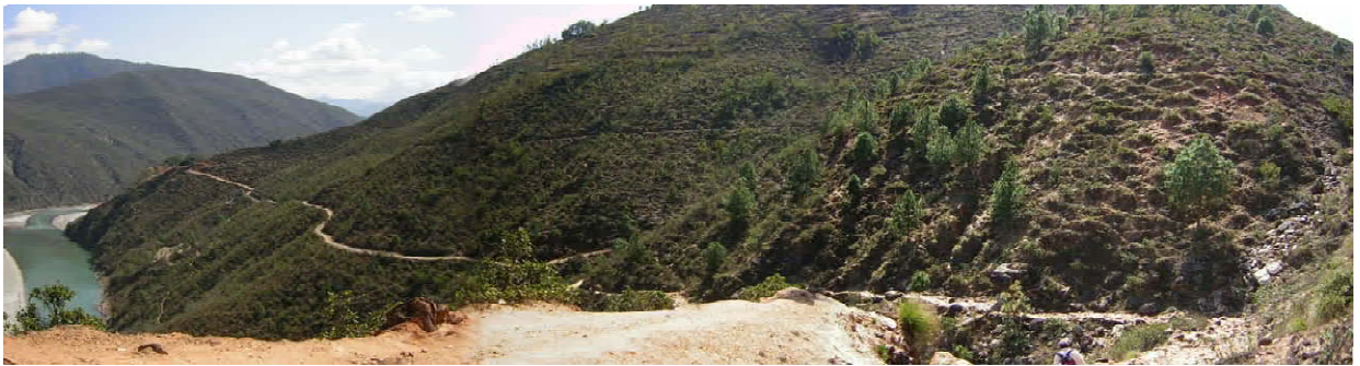
写真 G-2 STA. 7+600 の右より起点側を望む
