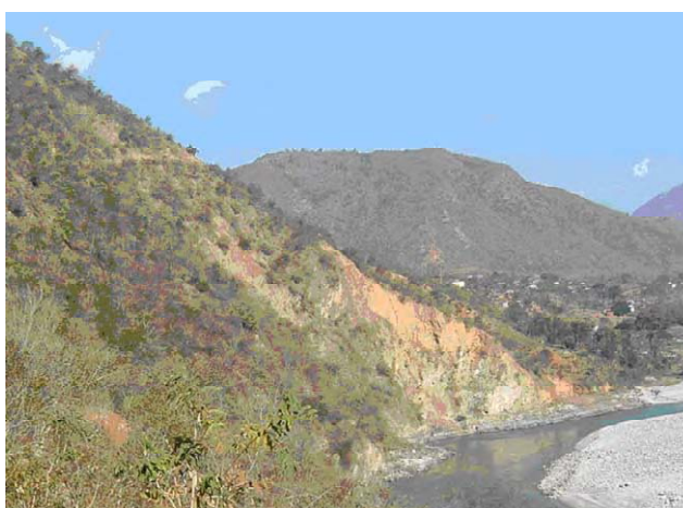
写真 G-1 STA2+800 付近の斜面崩壊
