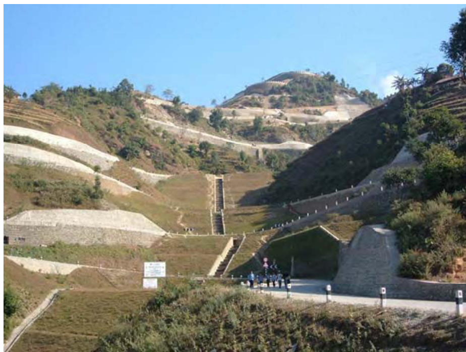
写真 G-6 シンズリ道路第2工区
