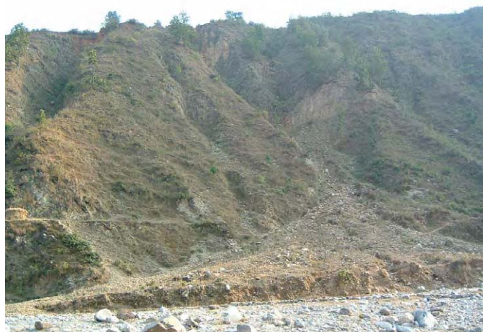
写真 G-5 STA.29+800 付近で形成中の崖錐
