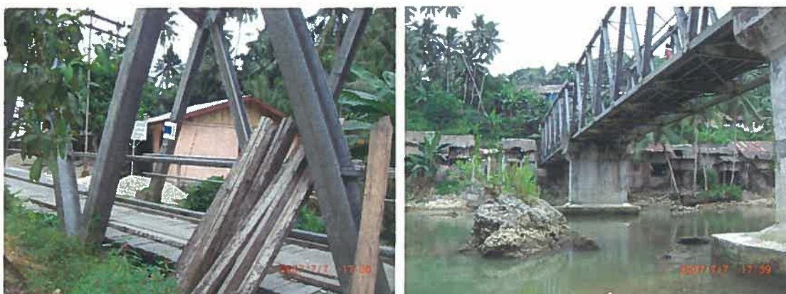
左：橋梁下流側左岸の背景、右：右岸の背景
