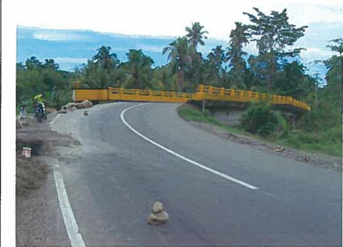
Gido Si'ite 橋：橋脚・橋台とも傾斜している。 橋の両側は直角に近い急カーブとなっている。
