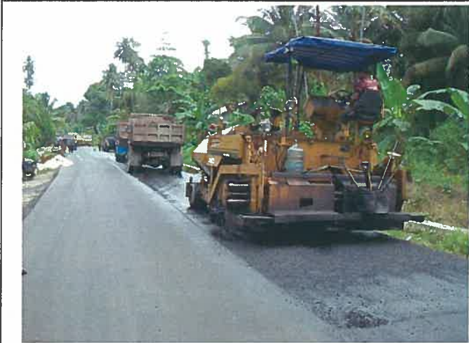
州道 75 号線上における道路舗装工事
