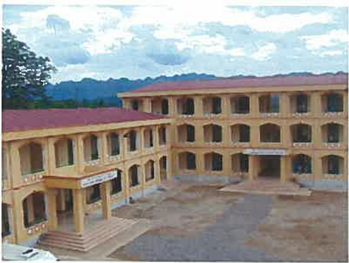
タンラック郡病院外観
