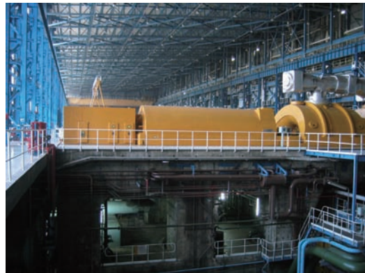
1号機タービン発電機 400MW (タービン：三菱重工、発電機：三菱電機)
