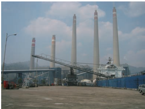
Suralaya 発電所全景 (揚炭栈橋から撮影)
