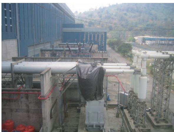
昇圧主変圧器、最も手前が修理中 (三菱電機製)
