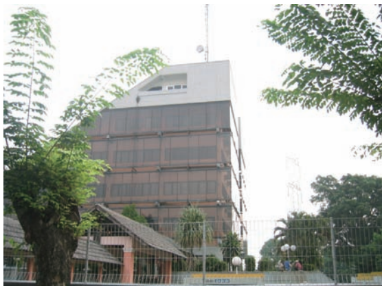
P3B JB ジャワコントロールセンター外観
