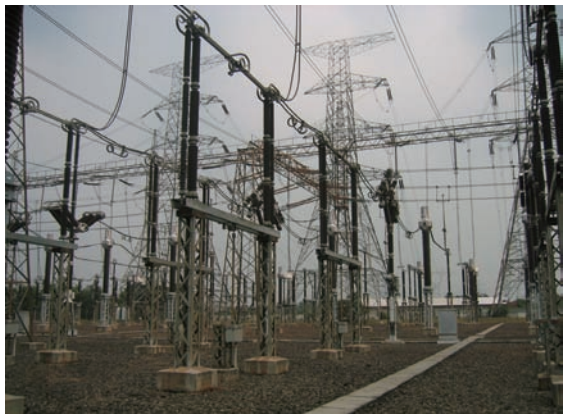
500kV 旧式空気遮断器、開閉器 (BBS ブラウンボヴェリ製)
