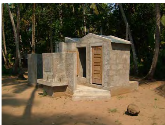
UNICEF のプロジェクトで建設された学校トイレ
