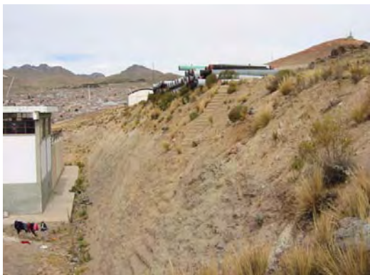
既存サンファン配水池背面の崖 （高低差約10m）
