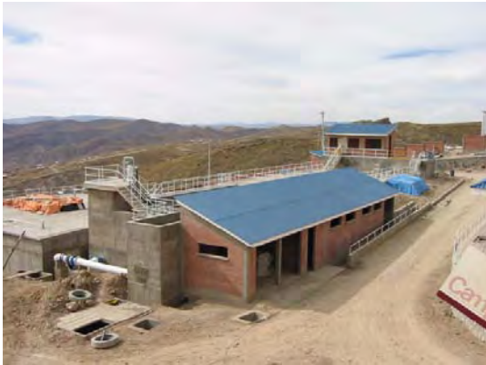
建設中のカリカリ浄水場全景
