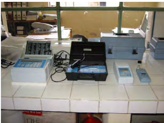
既存ミルネル浄水場のラボにある水質試験用機器（吸光光度計/電気伝導度 TDS 計/色度計）
