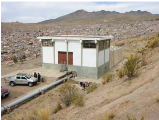
既存サンファン配水池全景
