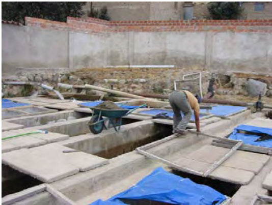
既存ミルネル浄水場緩速ろ過（砂ろ過）池の上部砂鋤取り作業風景
