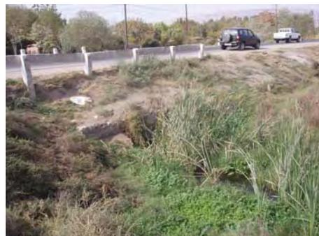
距離標 30+000 付近の横断管渠の土砂で埋まっている呑口
