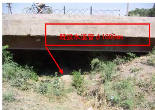
図 3.11 既設橋梁 No. 13 の既設水道管
