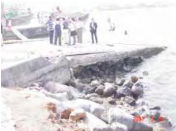
洗掘された斜路上部側基礎工。洗掘部分と鉄筋露出のヤード・斜路上側。舗装が宙吊り状態。
