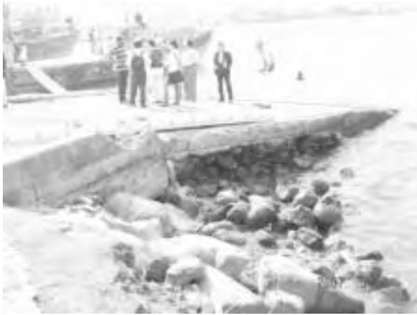
洗掘された斜路上部側基礎工
