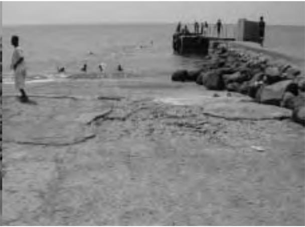
舗装のはがれた部分斜路とヤードの中間部分のほぼ全幅（11m）
