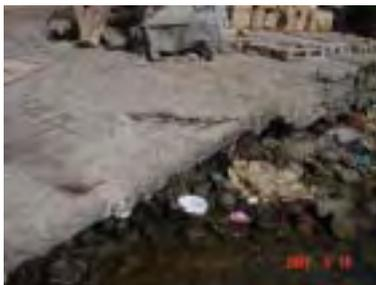
洗掘により舗装面下が空洞化している。
