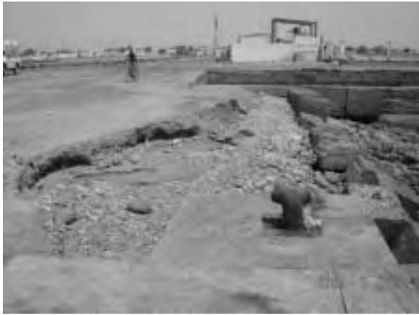
海側からの護岸崩壊ヤード洗掘箇所
