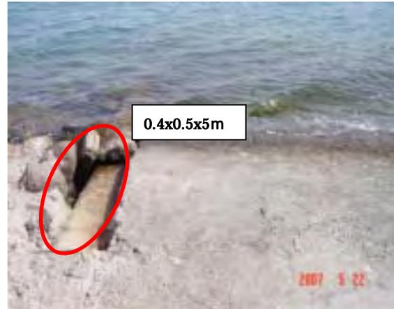
2基のドルフィン防舷材が欠損、消失。ヤード舗装は2001年に修復され良好。斜路上部の側壁が波に洗われ転倒放置されている
