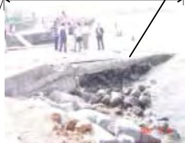
被覆石が飛散しているが空洞化には至っていない
