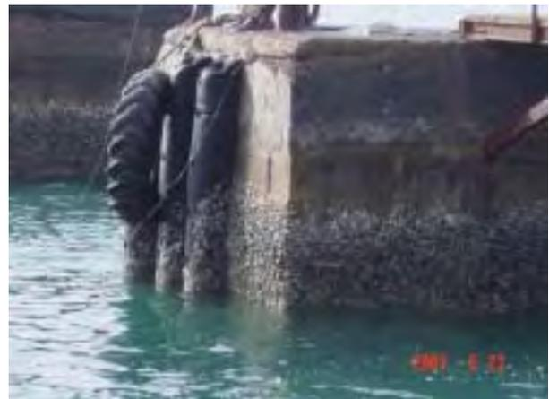
2基のドルフィン。1個のみ防舷材あり。ただし損傷。防舷材の高さ不足でタイヤを前面に載せている
