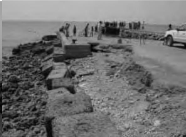
南側面のヤード護岸の崩壊と方塊ブロック
