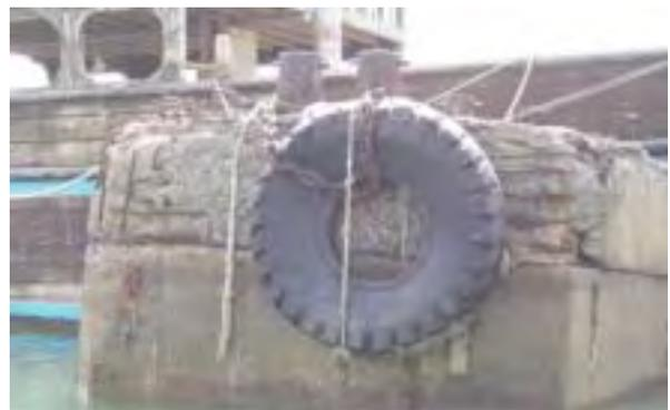
第 1 ドルフィン上部は鉄筋がむき出しである。鋼
