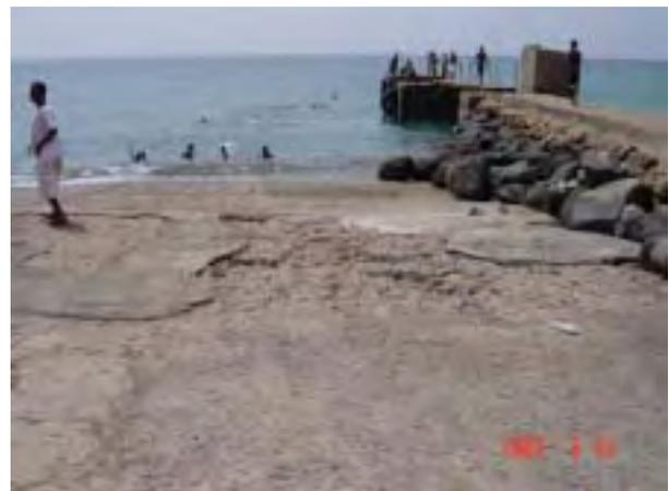
南側面のヤード護岸の崩壊と方塊ブロック。舗装のはがれた部分斜路とヤードの中間部分(11m)
