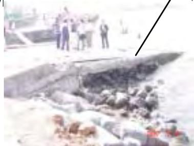
被覆石が飛散しているが空洞化には至っていない
