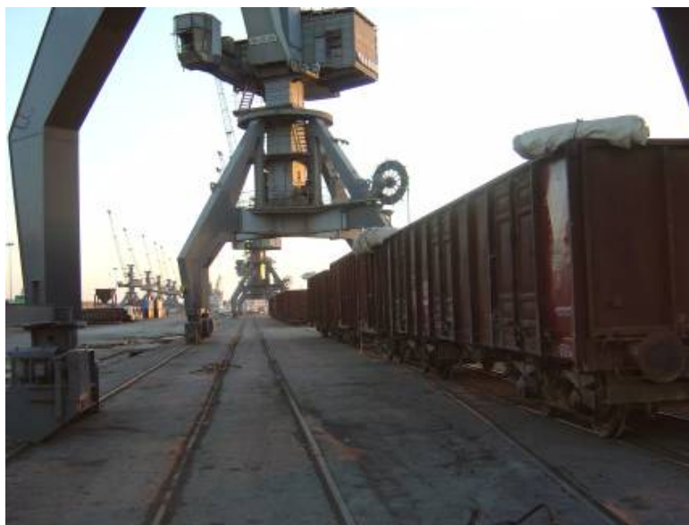
写真 2 - 10 在来貨物船バースの岸壁クレーン
