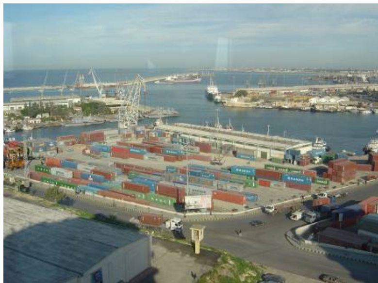
写真 2 - 4 ゲート No. 2 付近の空コンテナ置き場
