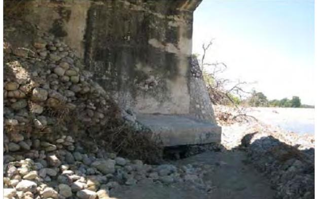
左写真の橋台基礎部も護岸の流失によりフォーチング下面が洗掘されている。ただし、杭基礎構造のため橋梁本体への被害は生じていない。
