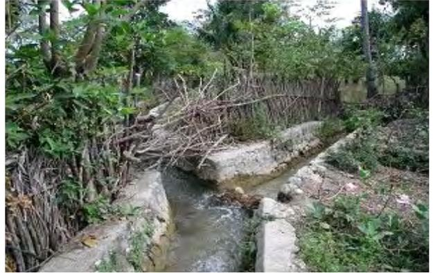
モラ川右岸側に河川に平行して設けられている灌漑用の用水路。新架橋ルートの取付道路は、同水路を超える計画となるため、日本側の工事範囲としてボックスカルバートにより重要な水路を確保する。
