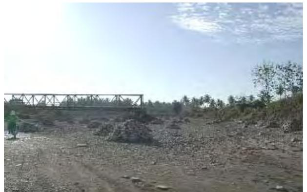
同洪水による被害：スアイの手前3km地点にある Camauase River の簡易トラス橋のスアイ側は河道のほぼ半分を5連のコルゲートパイプで抜く盛土構造としていたが流失、スアイ側橋台は沈下している。
