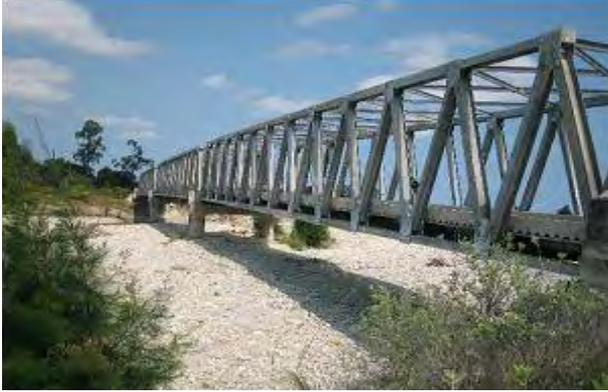
既設モラ橋(3連単純トラス橋)を河道中央に位置するスアイ側橋台下流側より望む。橋梁上下部工に損傷は見られないが、カーサ側橋台周辺(写真奥)は洪水による損傷が生じている(後述)。
