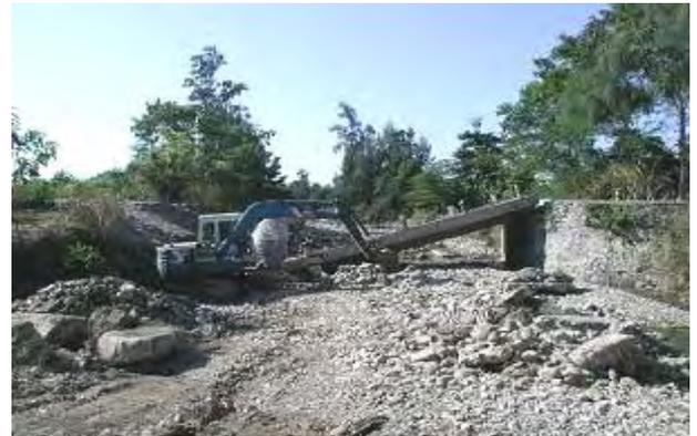
同洪水による被害：ズマライよりスアイに向かって8km地点にある Boraiken River に架かる橋の両端は、コルゲート管を含む突堤構造により河道を狭めていたが、ズマライ側橋台と共に流失した。
