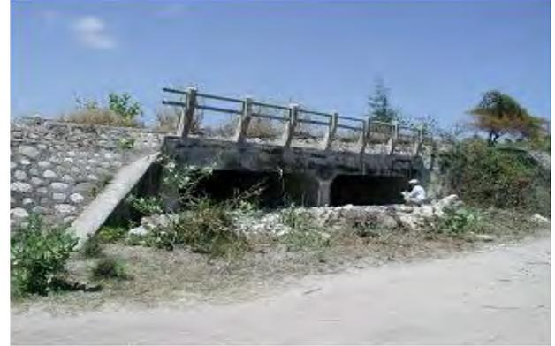
左写真のコルゲートパイプによる開口区間に続いて2連ボックスカルバートが建設されたが、開口面積は不足していたため、2000年の建設直後に増水により流失した。
