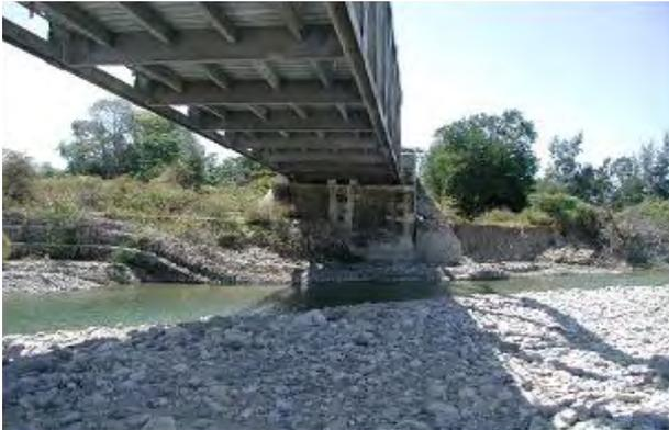
2007年6月22日～27日の連続降雨に伴う増水により、モラ川左岸は浸食を受け、橋台護岸工の基礎部が洗掘されふとん籠が沈下した。同降雨によりズマライの西側に架かる橋でも被害が発生した(写真-22以降)。
