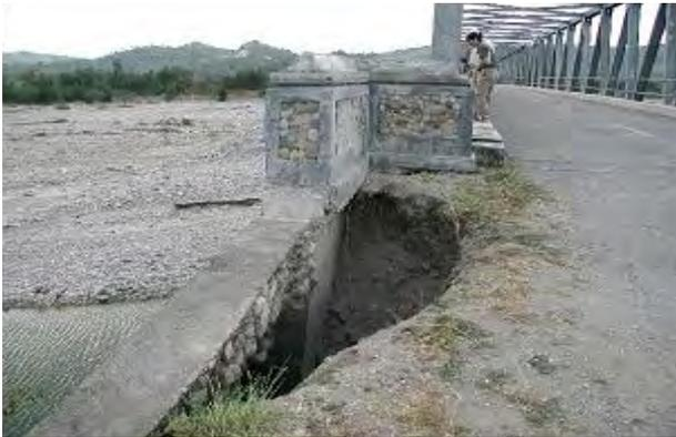
護岸工基礎部の沈下に伴い、練石積による袖擁壁は基礎部が沈下し大きな亀裂が入り、橋台背面の盛土が抜け落ち、擁壁脇に大きな穴が開いている。
