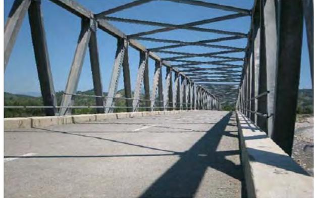
インドネシア標準の車道幅員6.0m(Bタイプ:2車線x3.0m)を有する橋面。舗装はサンドシートのため劣化が見られること、高欄となるパイプの一部に逸失はあるが、上部工本体に損傷は見られない。
