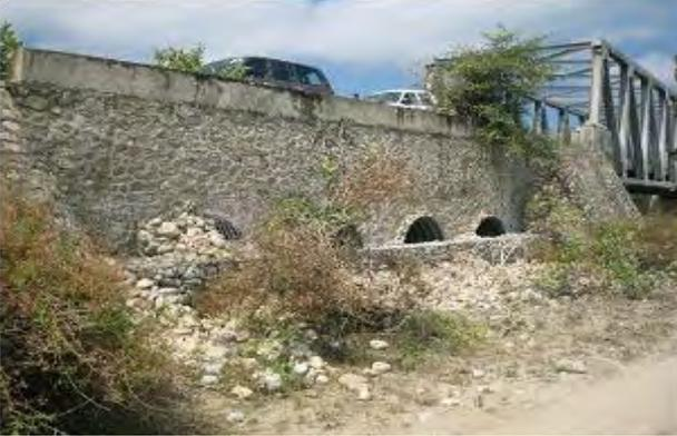
モラ川のスアイ側300mは2度に亘りカルバートを含む盛土構造で建設されたが流失した。写真は2000年にカナダの施工業者により建設され残存する5連のコルゲートパイプを含む取付道路部分。
