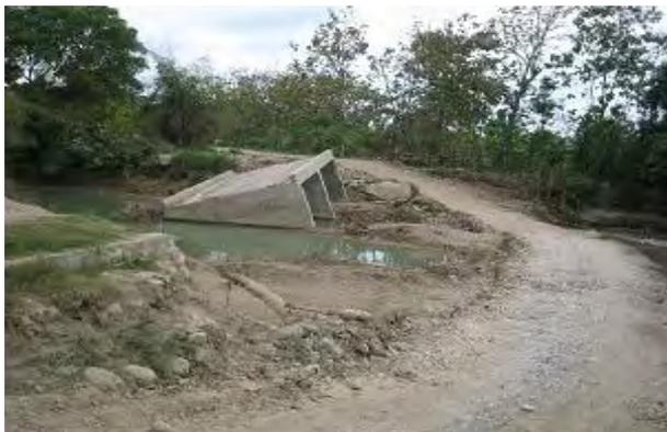
同洪水による被害：スアイの手前4km地点にある Samfuk River に設けた2ボックスカルバートは、上流側(写真左側)が洗掘により大きく沈下すると共に、河道を閉塞していた取付道路盛土部が流失した。
