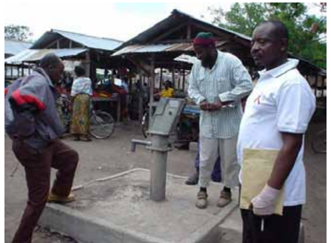
政府による深井戸(深度30m DDCA掘削) Water User's Groupが管理、水料金は Tsh.1/L (Tabora州 Nzega市 Nzega Market)
