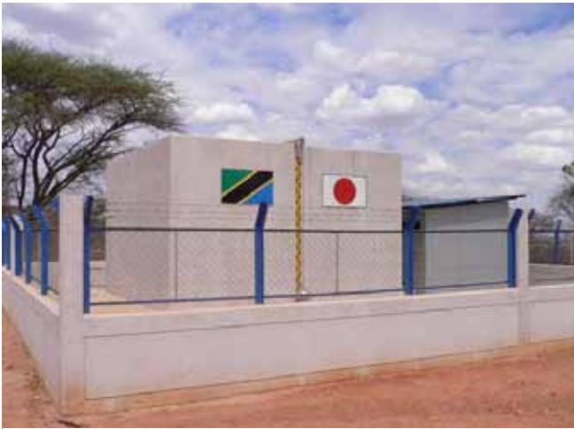
無償中央高原地域水供給計画サイト内上水道施設
