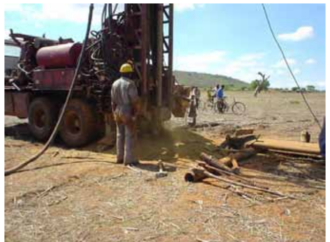
Water Aid援助の井戸掘削現場(DDCAによる掘削作業中) (Tabora州 Maluzilo村)
