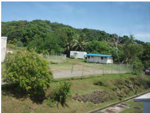
発電機建屋候補地地点 (青い屋根の建物等を撤去して構内道路沿いに建設)
