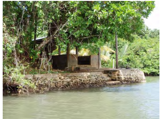
発電所の最も近い住宅（4～5戸）用 船着場（住宅はこの奥にある）
