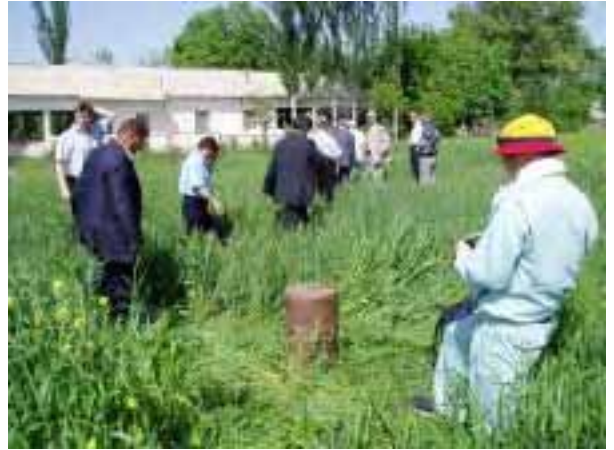
写真-10 【メハナタバッド・ジャモアット、メハナタバッド村未利用井戸】 同村内のケンジャ・アブドルにある1985年に建設された未利用の井戸。本井戸を利用し、現在給水状況が悪い2村(ナババッド村、グリヤバッド村)への給水施設を建設する。
