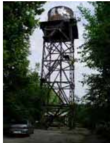
写真-4 【モスクワ町ボドカナル高架水槽】 鋼製タンク容量100m 3 。高さ20m。老朽化による漏水と、天井部が撤去されたため現在は使用されていない。井戸ポンプ能力が低く、高架タンクまで水を揚げる事ができないため、タンクを通さずに直接給水されている。
