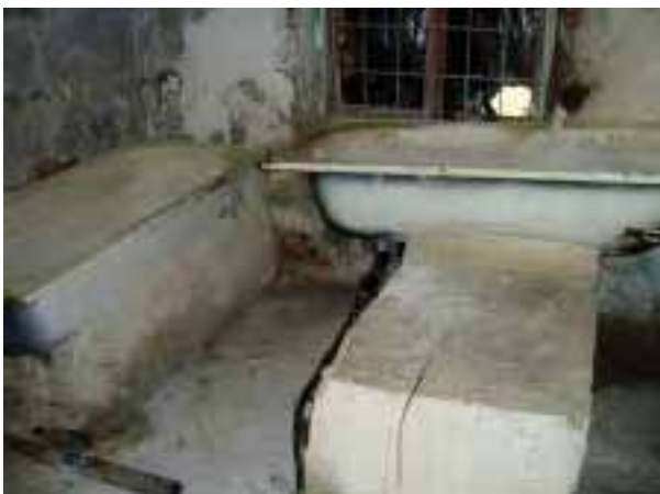
写真-3 【モスクワ町ボドカナル塩素注入器】 さらし粉をバスタブで溶解し、井戸に注入し滅菌を行なっている。そのため、鋼製ケーシング内面の腐食が顕著である。
