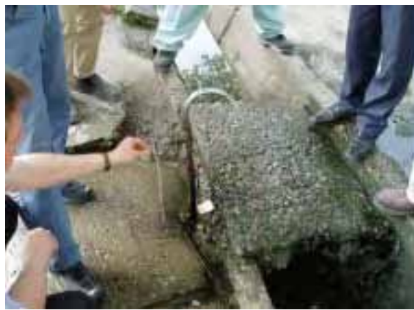
写真-6 【モスクワ町共同水栓】 2階建ての集合住宅の家庭用に、道路脇に設置された共同水栓。現在全市には32箇所ある。
