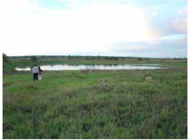
Mitindo ダム(1955 建設)の貯水池 (Mwanza 州 Misungwi District, Kijima Village)
