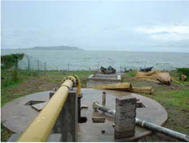
ビクトリア湖からの取水地点 (Mwanza 州 New Magu Intake Pump Station)
