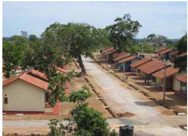
Construction of Hijra Nagar JSFV (August 2007)
