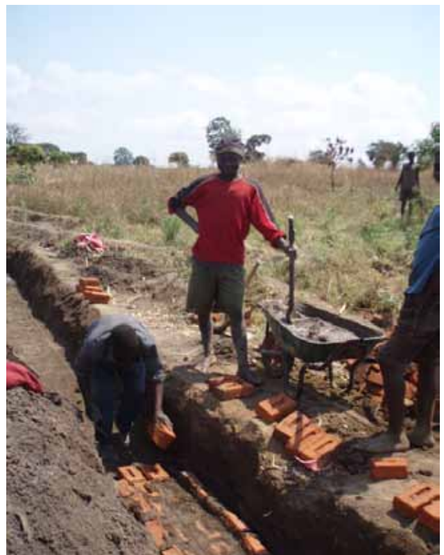
砂地で水の浸出が多いため、住民で資金を出し合ってレンガを購入・ライニングを実施
