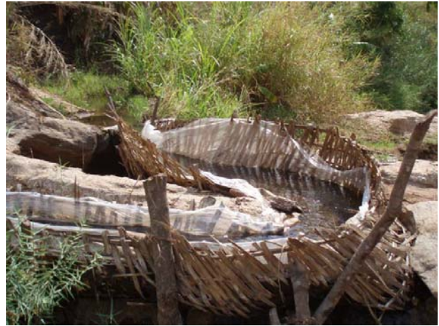
編んだ竹に漏水防止用のビニールをしいた水路
