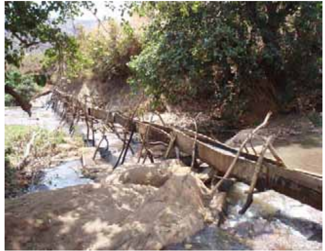
木枠にビニールシートを敷いた水路橋
