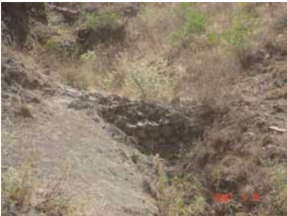
流出路のチェックダム
