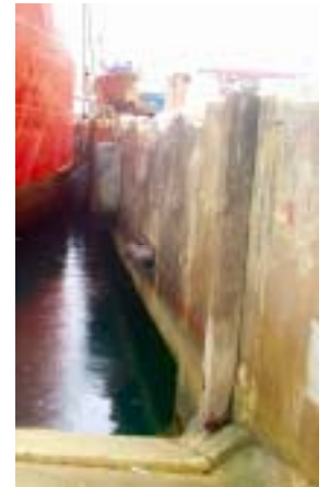
図 2-15 スクアロファ 港岸壁フェンダー
