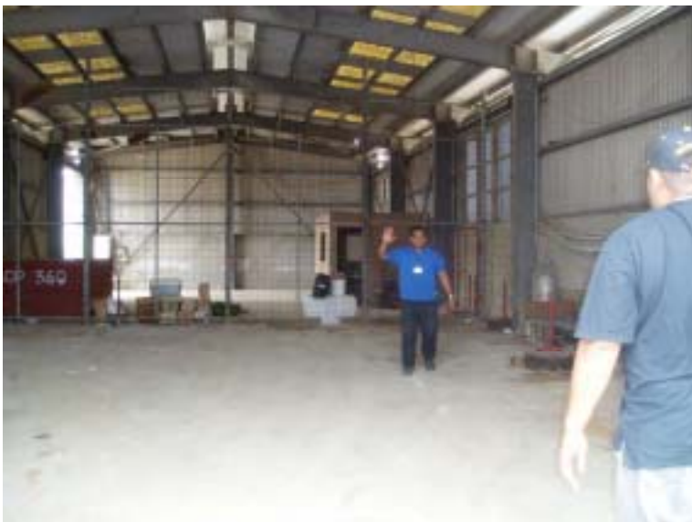
ヌクアロファ港の貨物集荷倉庫
