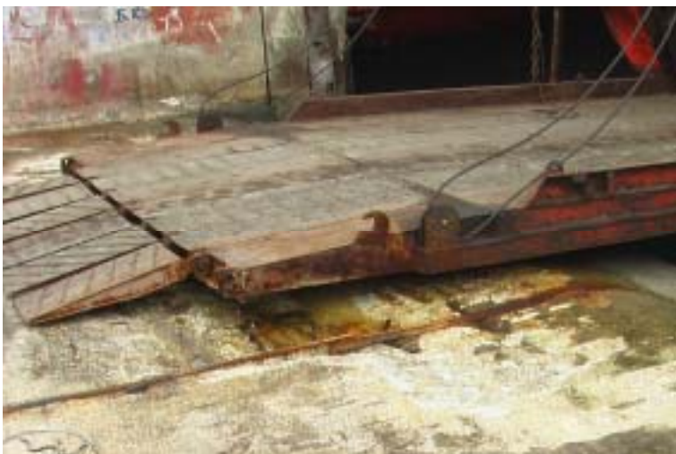
岸壁スロープ上に置かれたランプ
