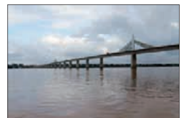
2006年12月に開通した第二メコン国際橋 (写真提供 山九株式会社)
