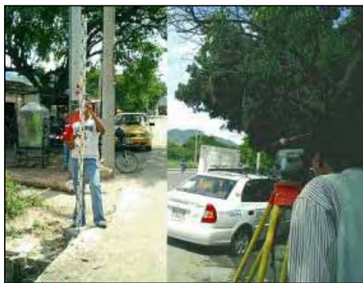
Verificación de datos de elevación por nivelación directa
