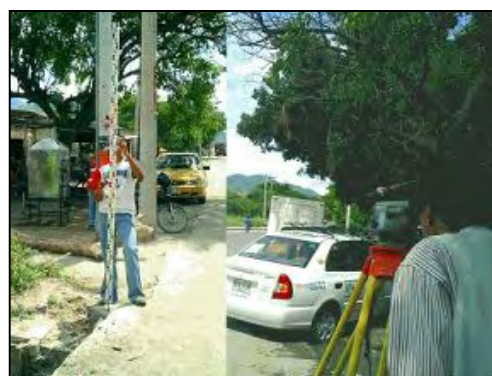
直接水準測量による標高値の検出
