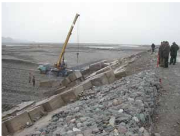
Демонтаж существующих бетонных кубиков (18 января 2007)
