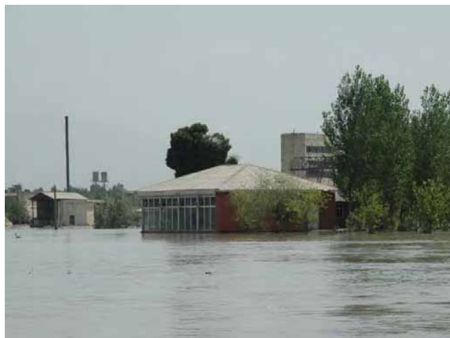
Паводковое состояние в Хамадони -2 (Июль 2005)
