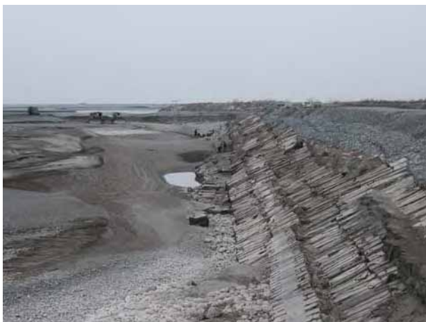
Состояние существующего крепления откосов до строительства (4 января 2007)
