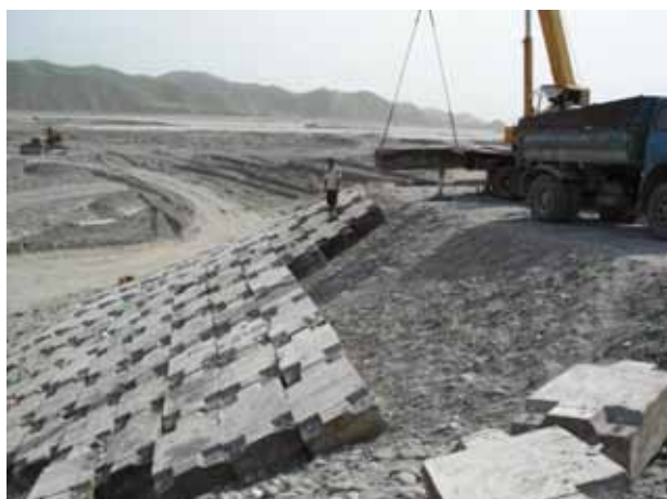
Работы по защите откоса на Ш1 (16 апреля 2007)
