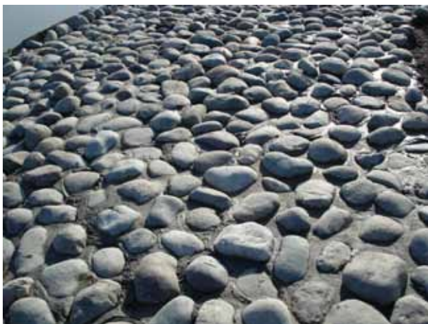
Укладка мокрого камня на Ш2 (2 апреля 2007)
