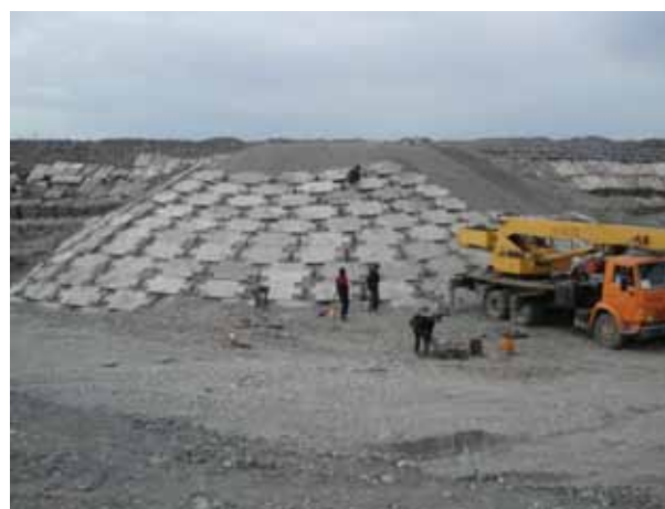
Работы по защите откоса на Ш2 (24 марта 2007)
