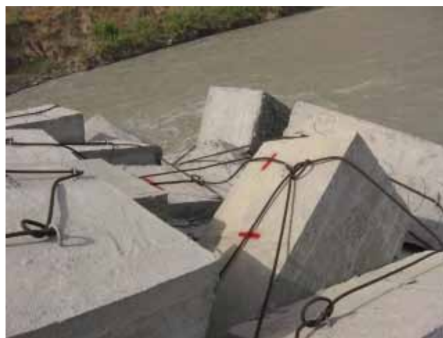
Конец верхней точки направляющей дамбы головного сооружения (Июль 2007)
