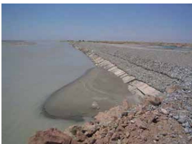
Крепление откосов бетонными кубиками и габионом (Июль 2006)
