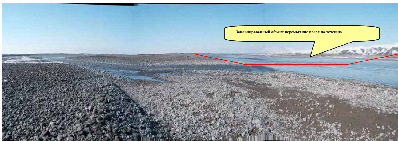
До строительства перемычки (Декабрь 2006)
