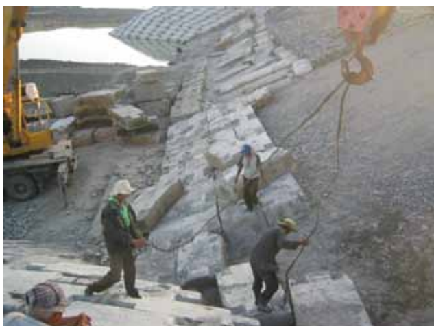
Работы по защите откосов Ш1 вниз по течению (20 апреля 2007)
