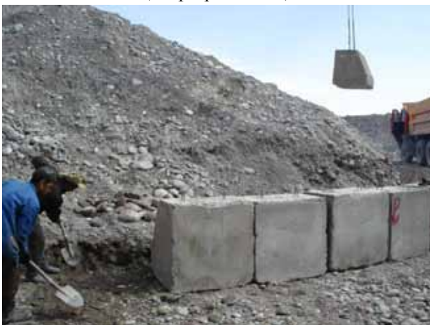
Бетонные кубики для основания на Ш2 (7 марта 2007)
