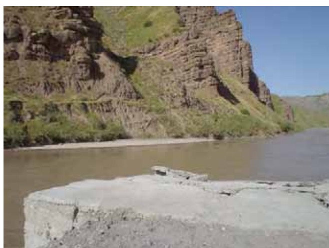
Конец верхней точки направляющей дамбы головного сооружения (Апрель 2006)
