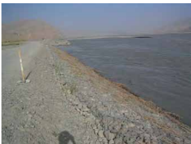
Крепление откосов габионного типа (Сентябрь 2006)
