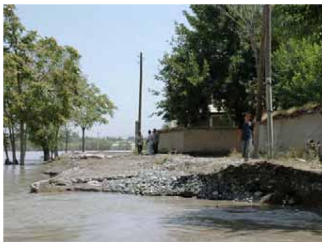
Паводковое состояние в Хамадони -4 (Июль 2005)
