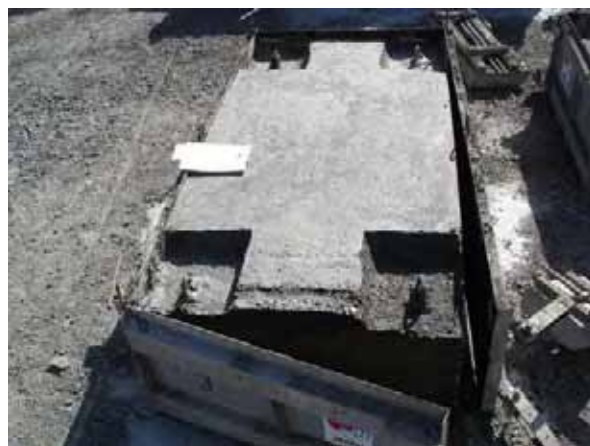
Снятие металлической формы (10 мая 2007)
