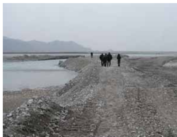
Завершение перемычки (10 января 2007)
