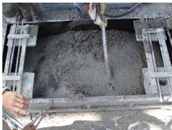
Уплотнение бетона (3 мая 2007)
