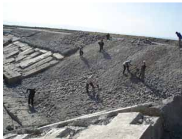
Отделка и очистка откоса Ш1 вниз по течению (18 апреля 2007)
