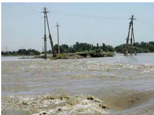
Паводковое состояние в Хамадони -5 (Июль 2005)
