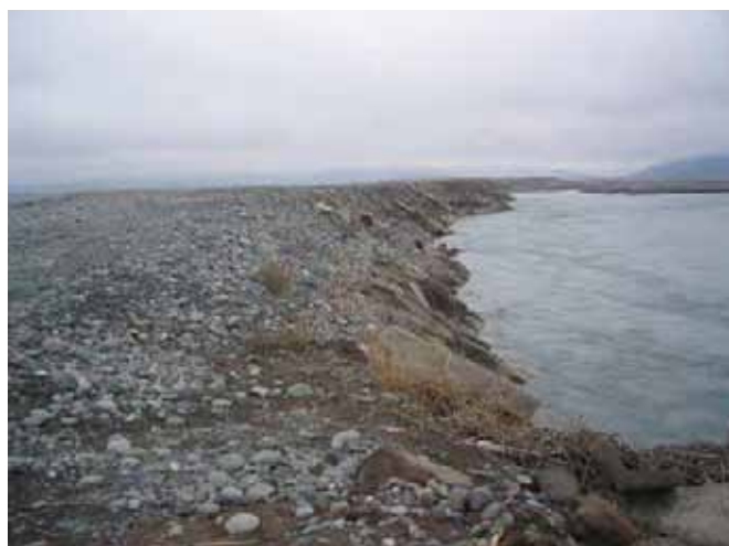
Временный монтаж бетонных кубиков для защиты от береговой эрозии на репере 9.2км (Декабрь 2006)
