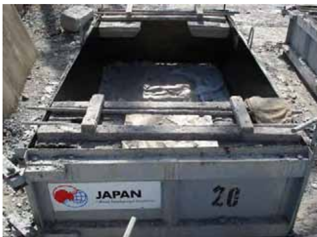
Установка металлической формы (3 мая 2007)
