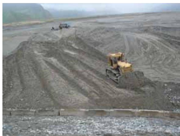
Работы по обратной засыпки на Ш1 (30 марта 2007)
