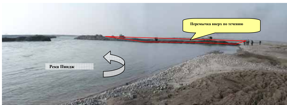
Идет строительство перемычки вверх по течению (Декабрь 2006)
