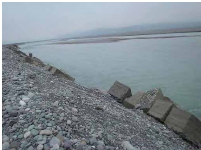
Временный монтаж бетонных кубиков для защиты от береговой эрозии на репере 6.7км (Декабрь 2006)
