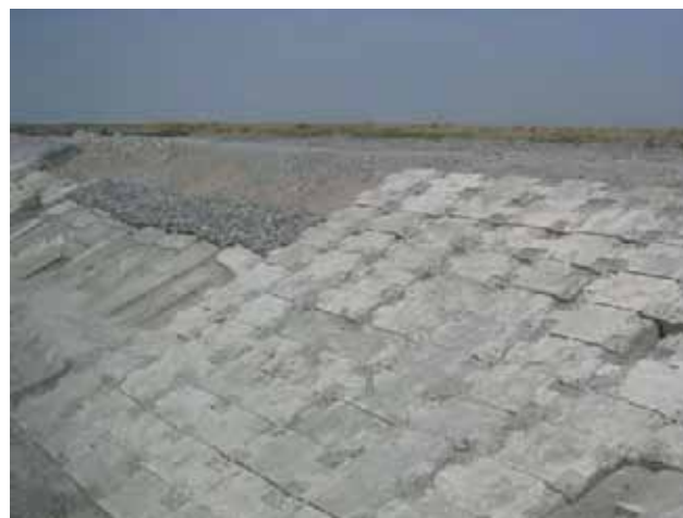
Работы по защите откосов Ш1 вниз по течению (28 апреля 2007)
