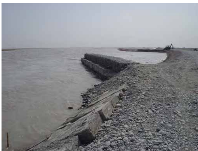
Шпора из бетонных кубиков на основной дамбе (Май 2006)
