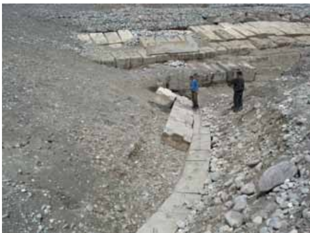
Работы по защите откоса на Ш1 (29 марта 2007)
