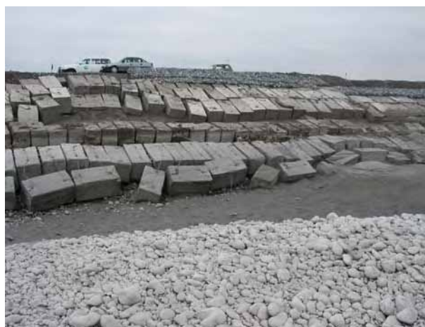
Состояние существующего крепления откосов до строительства (4 января 2007)
