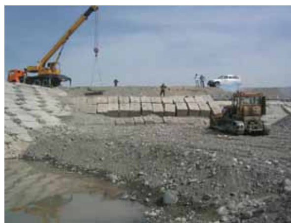
Демонтаж существующих бетонных кубиков (2-го мая 2007)
