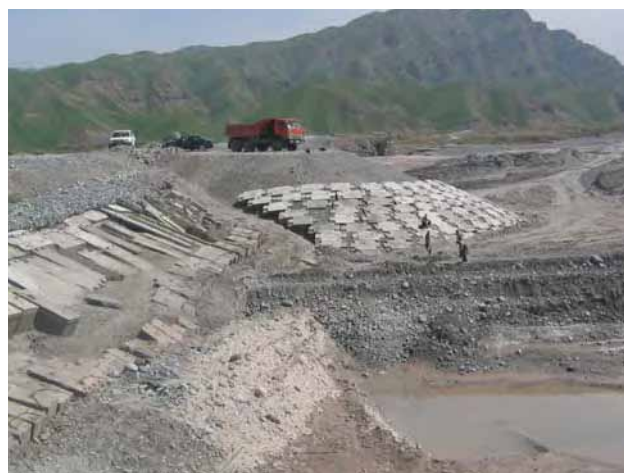
Работы по защите откоса на Ш1 (10 апреля 2007)
