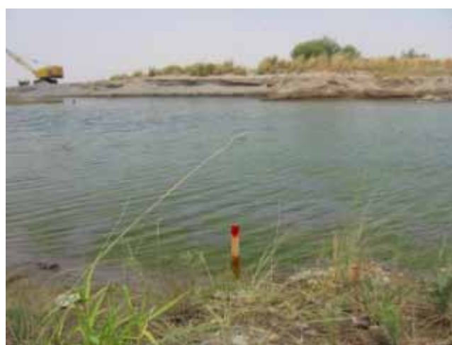
Точка просачивания на репере 8.4км (Июль 2007)
