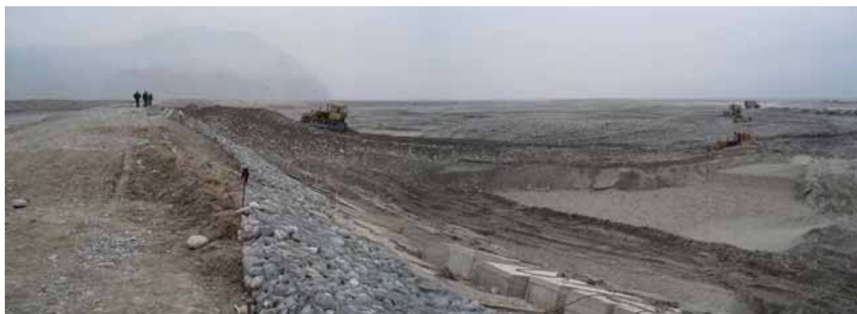
Сооружение насыпи Ш1 (11 января 2007)
