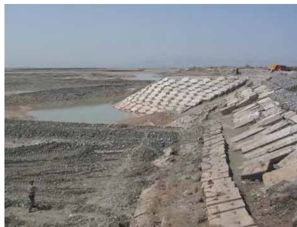
Работы по защите откоса на Ш2 (10 апреля 2007)
