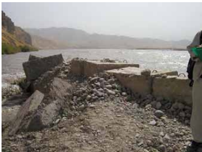
Конец верхней точки направляющей дамбы головного сооружения (Август 2006)
