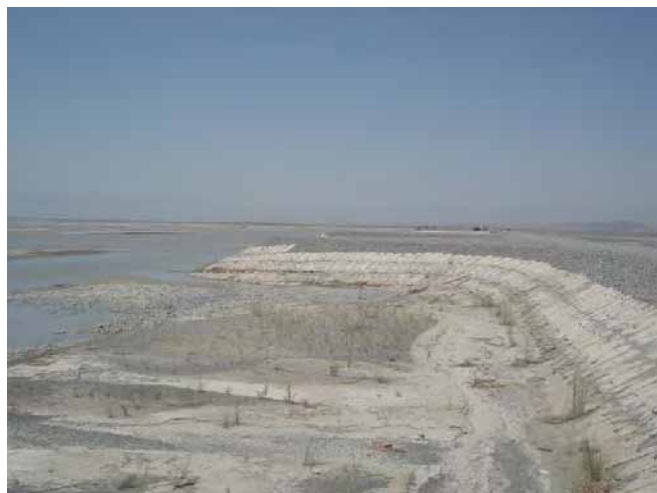
Закругленная шпора, построенная в 2007 (Июль 2007)
