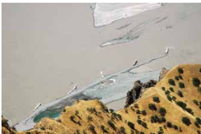
Направляющая дамба головного сооружения (Июль 2006)
