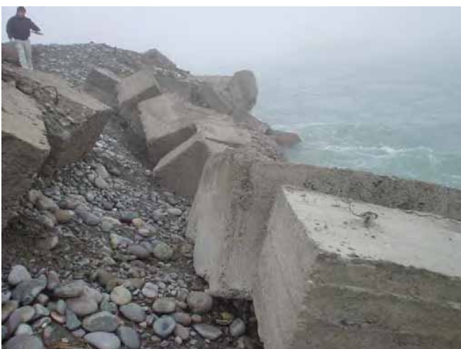
Размыв русла реки и неправильный бетонный кубик на репере 3.5км (Декабрь 2006)
