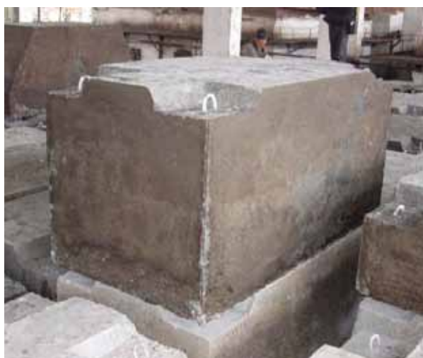
Завершение бетонного кубика: 2.0м x 1.0м x 1.0м
