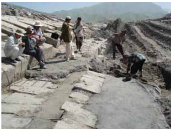
Заполнение пустоты между бетонными кубиками на крепление откосов вверх Ш1 (15 апреля 2007)
