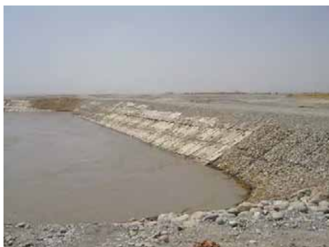
Крепление откосов бетонными кубиками (Август 2006)
