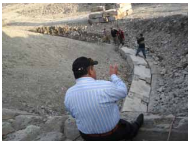
Работы по защите откоса на Ш2 (20 марта 2007)
