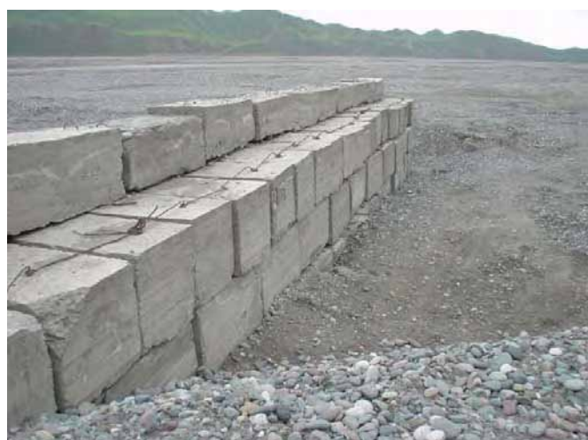
Шпора из бетонных кубиков на направляющей дамбе (Март 2006)
