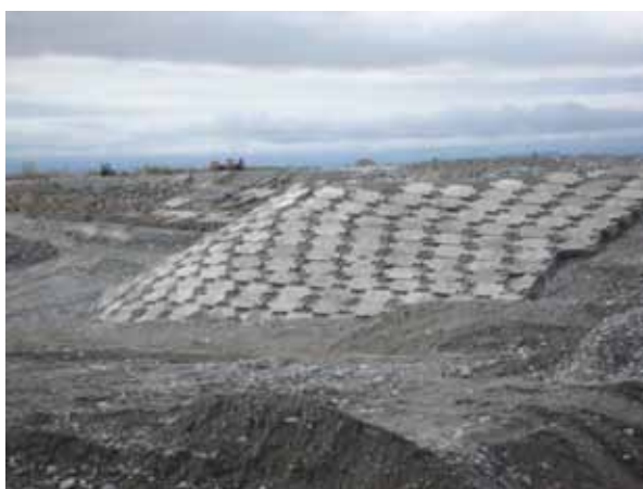
Работы по защите откоса на Ш2 (30 марта 2007)
