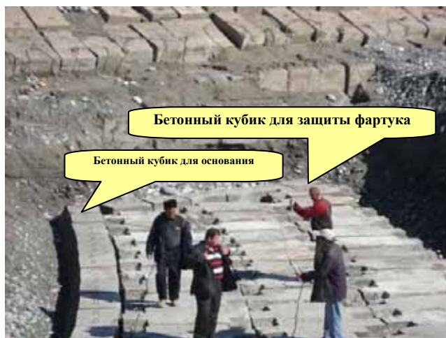
Бетонный кубик для основания и защита фартука бетонным кубиком на Ш1 (20 марта 2007)
