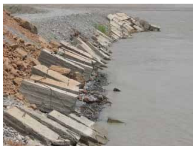
Временный монтаж бетонных кубиков для защиты от береговой эрозии на репере 3.2км (Июль 2007)
