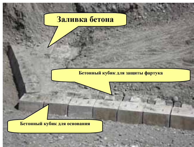
Бетонный кубик для основания и защита фартука бетонным кубиком на Ш1 (24 марта 2007)
