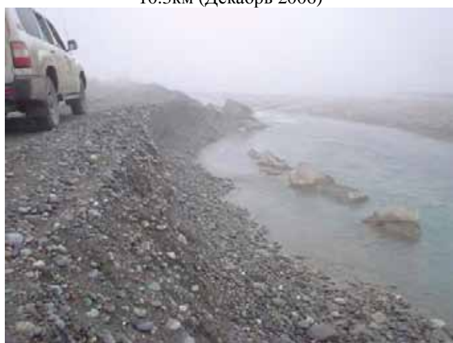
Временный монтаж бетонных кубиков для защиты от береговой эрозии на репере 11.3км (Декабрь 2006)
