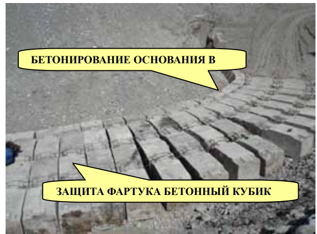
Бетонные кубики для основания и защиты фартука на Ш2 (6 марта 2007)
