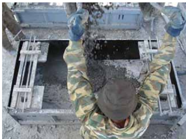
Заливка бетона в металлическую форму (3 мая 2007)
