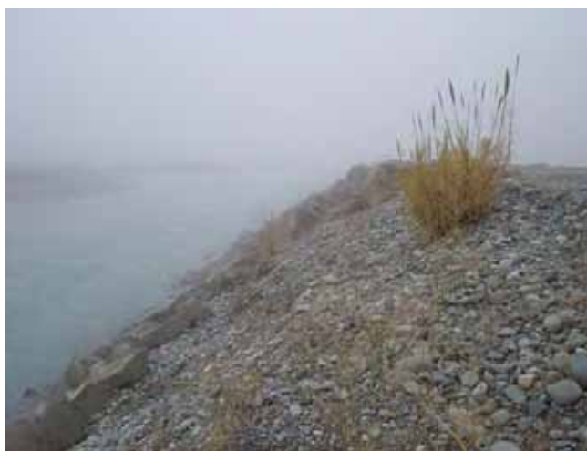
Смытое крепление откосов на репере 3.0км (Декабрь 2006)
