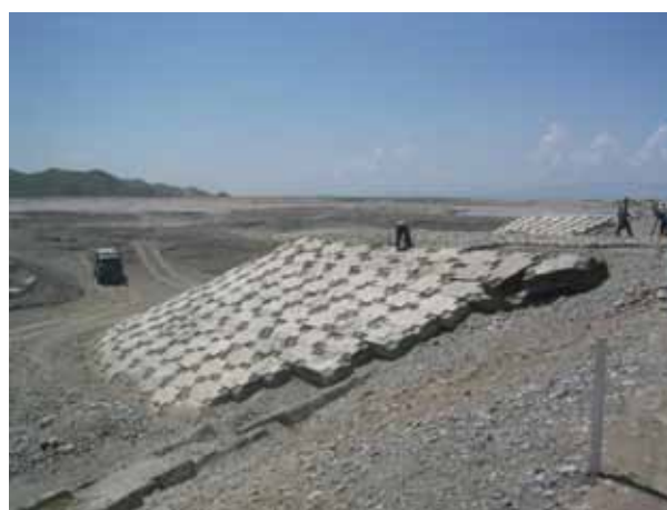
Работы по защите откоса на Ш1 (23 апреля 2007)
