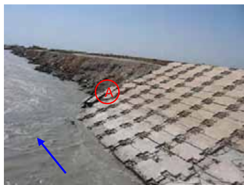
Рис. R 11.4.4 Разрушение основной дамбы 2 (25 июля) Рис. R 11.4.3 Разрушение основной дамбы 2 (1 сентября)
