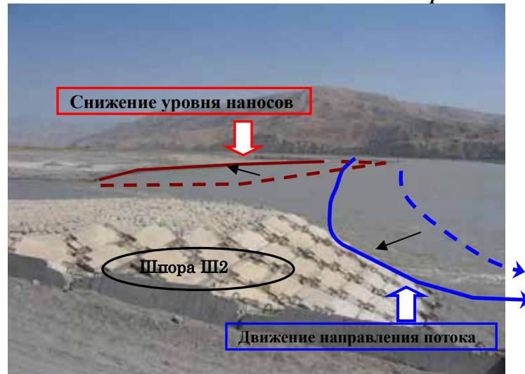
Рис. R 11.4.6 Движение лицевой стороны водного удара
