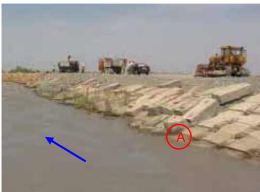
Рис. R 11.4.4 Разрушение основной дамбы 2 (25 июля) Рис. R 11.4.3 Разрушение основной дамбы 2 (1 сентября)
