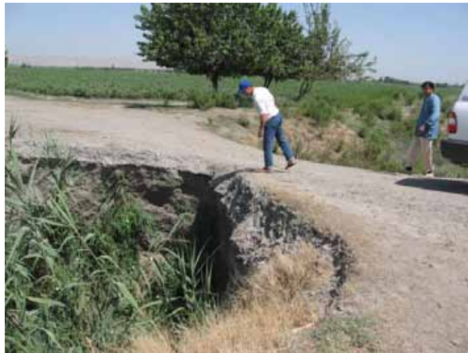
Рис. Р 8.8.2 Водопропускная труба покрыта асфальтом в эвакуационный маршрут #3 между Советобод и Икбол в джамоате Турдыев
