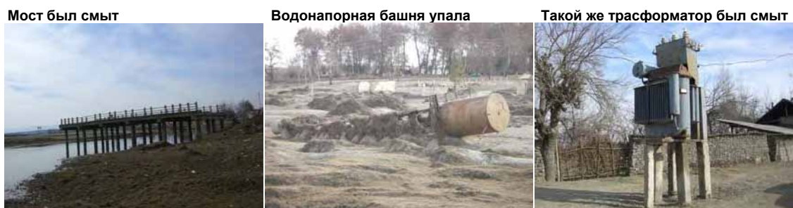
Рис. R 9.2.3 Некоторые общественные структуры разрушены при паводке 2005 года
