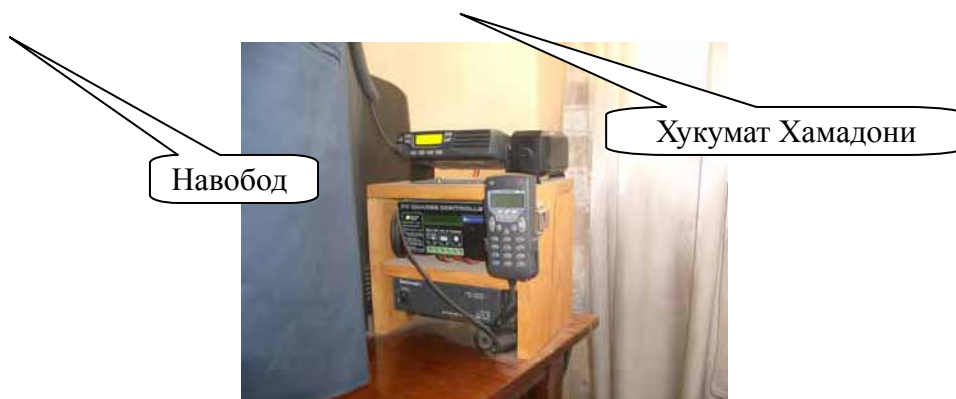
Рис. R 8.4.9 Базовая станция УКВ и радио (коротковолновая радиосвязь ) в Хукумате Хамадони
