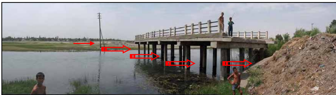
Основной корпус моста (длина 20.0 м, ширина 8.0 м) не был разрушен паводком
