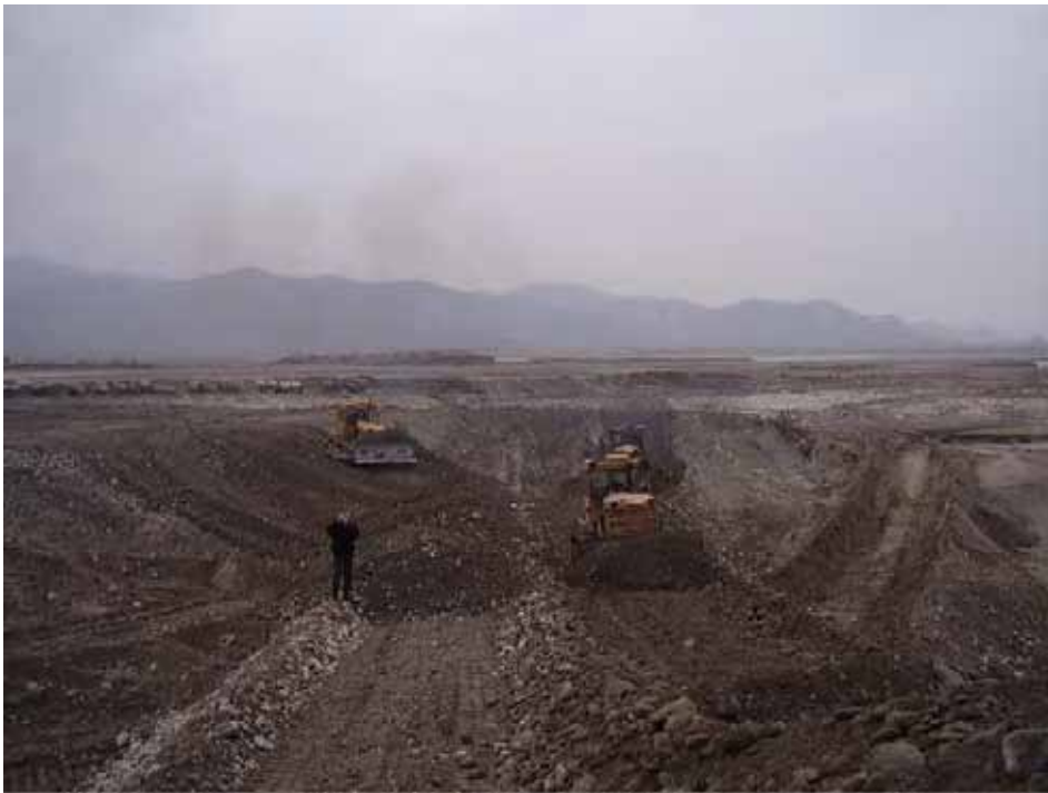
Рис. R.7.3.3 __Машины в строительной площадке пилотного проекта
