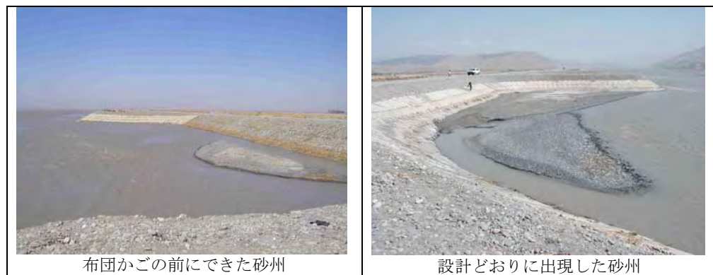
図. R. 2. 5. 2 水制工の下流側にできた砂州
