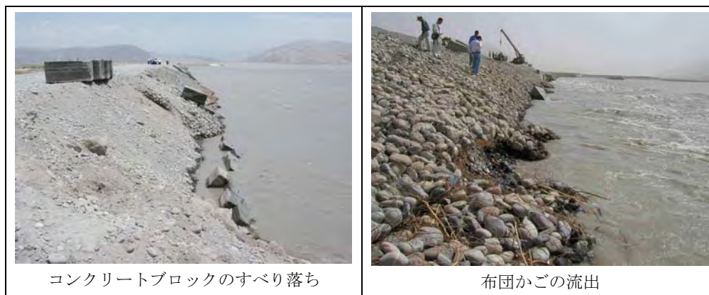
既設堤防の破損状況
