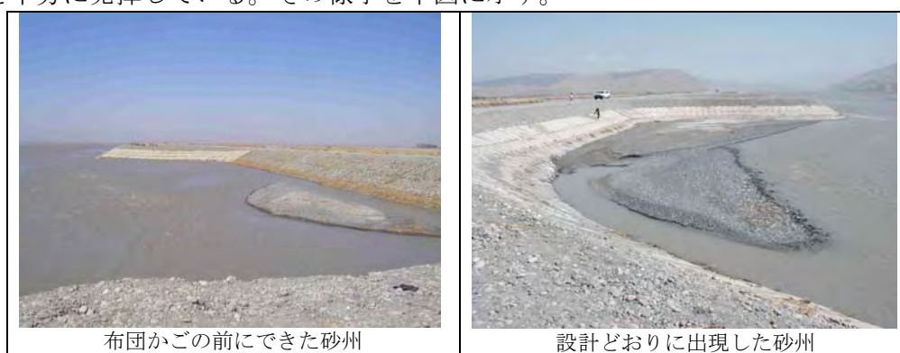
水制工の下流側にできた砂州
