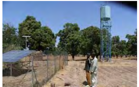
ソーラー発電システムを利用した既設のレベル 2 給水施設（カディオコ県、DANIDA の援助による）
