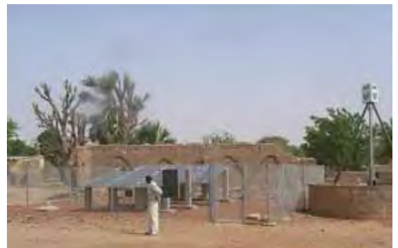
ソーラー発電システムを利用した既設のレベル 2 給水施設（セゲー州、EU の援助による）
