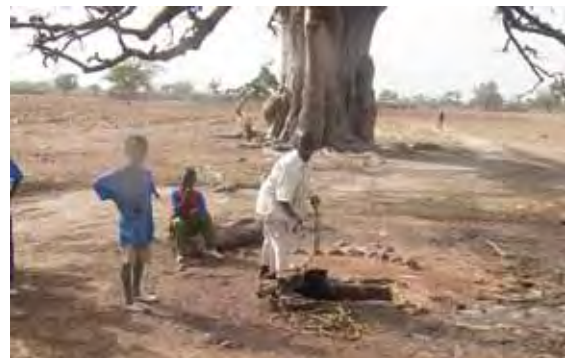
伝統的浅井戸（素掘りのままで井戸口のプロテクトがなく劣悪な状況）
