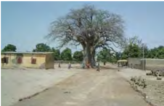
村落へのアクセス道路（大部分の道路はラテライトにより舗装され雨期のアクセスも比較的良好）
