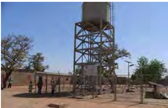
ソーラー発電システムを利用した既設のレベル 2 給水施設（クリコロ州、日本の援助による）
