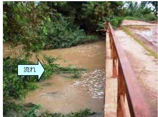
2) オダ川での水位上昇の様子（桁下直近まで水位が上昇している）（2007年7月29日撮影）
