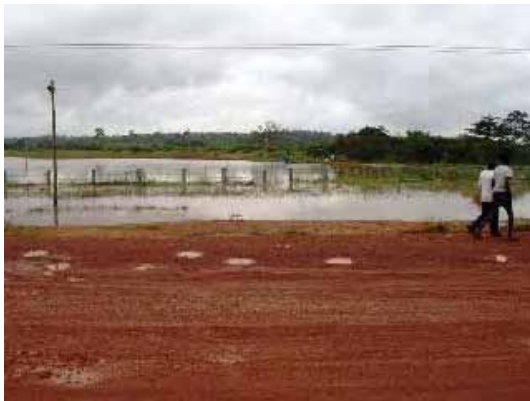
1) 河川の氾濫の状況（橋梁の上流側）（2007年7月29日撮影）
