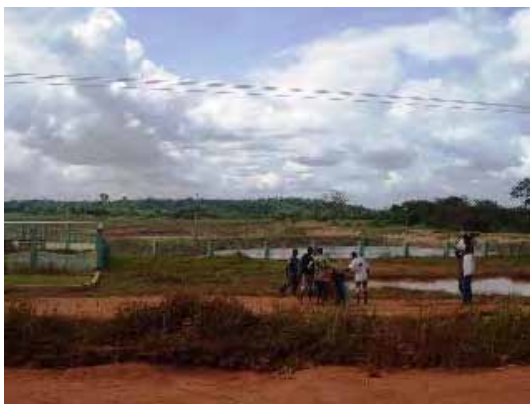
3) 水位が低下しフィッシュポンドが現れたオダ川周辺の状況（橋梁の上流側）（2007年8月10日撮影）
