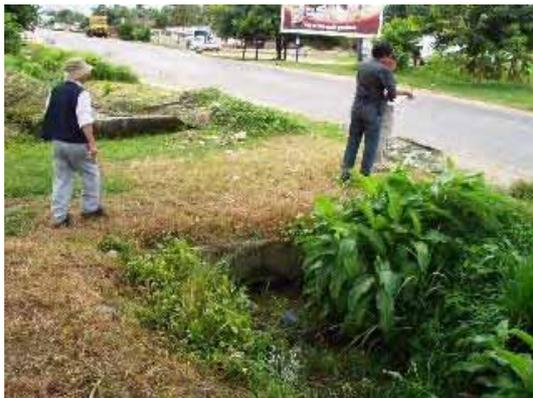
パイプの径が小さく清掃が十分に行われなため、パイプが目詰まり (67km 付近、アシン・フォス橋の南)
