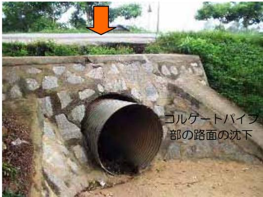
重車両の走行振動でコルゲートパイプ周辺の土砂が緩みコルゲート上の路面が沈下 (95km 付近、アシン・プラソ橋の南)
