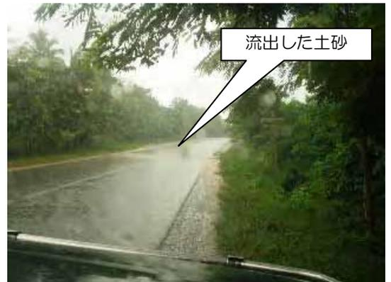
縦断排水の不良により周辺切土の表面水が路面に流れ出て滞留 (90km 付近)
