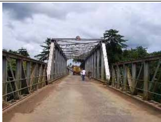
写真 3-4 橋梁 (アシン・プラソ)
