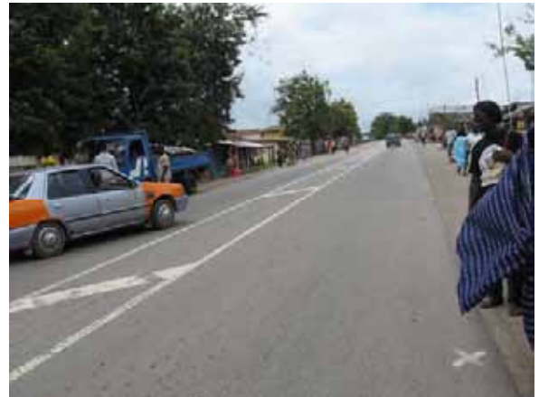
写真 4-4 道路周辺状況 おおむね 5km 毎に集落がある。
