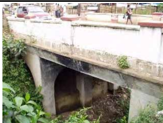
写真 3-2 橋梁 (アシン・フォス)
