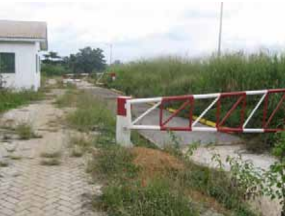
写真 4-5 道路周辺状況 過積載取締りのための検問所 (オブワシ JCT 南) 施設は建設されているがまだ使用されていない。
