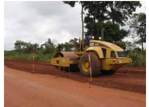
写真 4-6 道路周辺状況 アンウィアंकワクタから 16km 区間の改修工事作業の様子 (路床転圧中)
