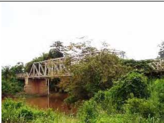
写真 3-3 橋梁 (アシン・プラソ)
