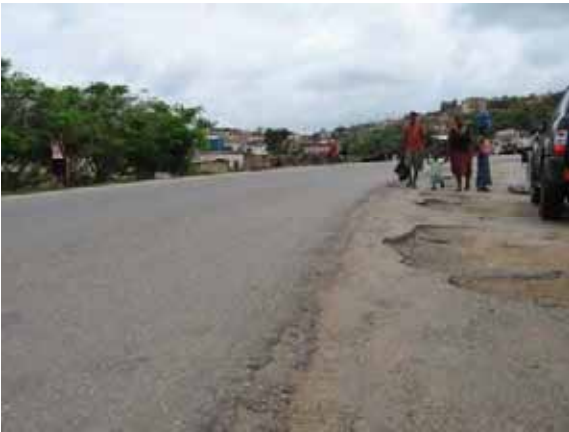
写真 4-3 道路周辺状況 (ヤモランサ) ヤモランサ付近、マーケットがあり歩行者や停車車両が多い。
