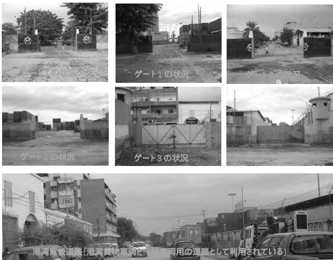
図 3-2-4-2.(6) 計画対象ヤードのゲートと港湾区域に隣接した一般道路
