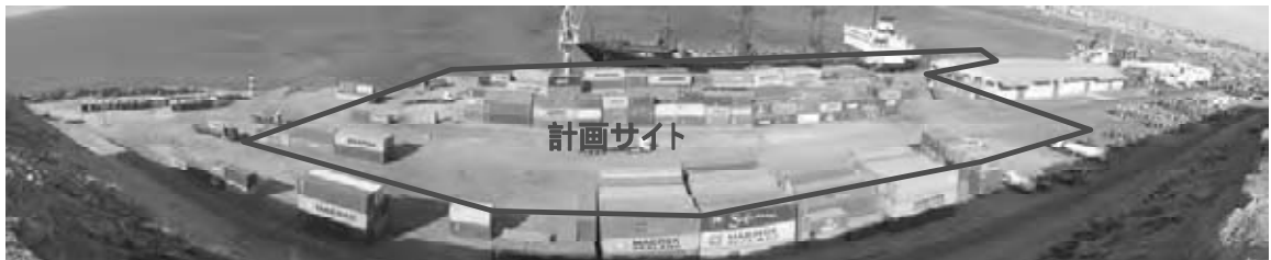
図 3-2-4-2.(7) 計画サイト内に密集するコンテナヤード(先方政府による移設が予定)
