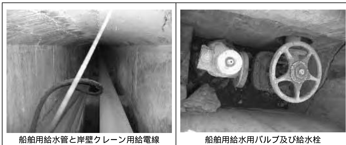
図 2-1-4.(6) ロビト港給水管
