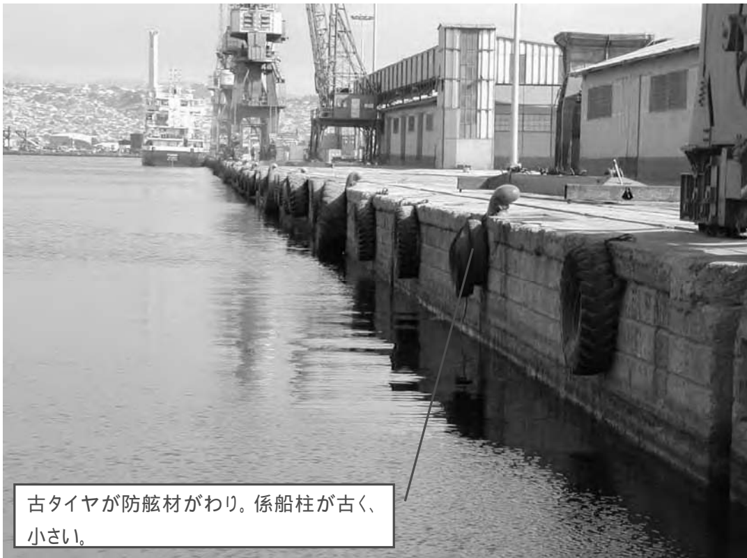
写真 - L5 ロビト港 No.5～8 岸壁前面状況
