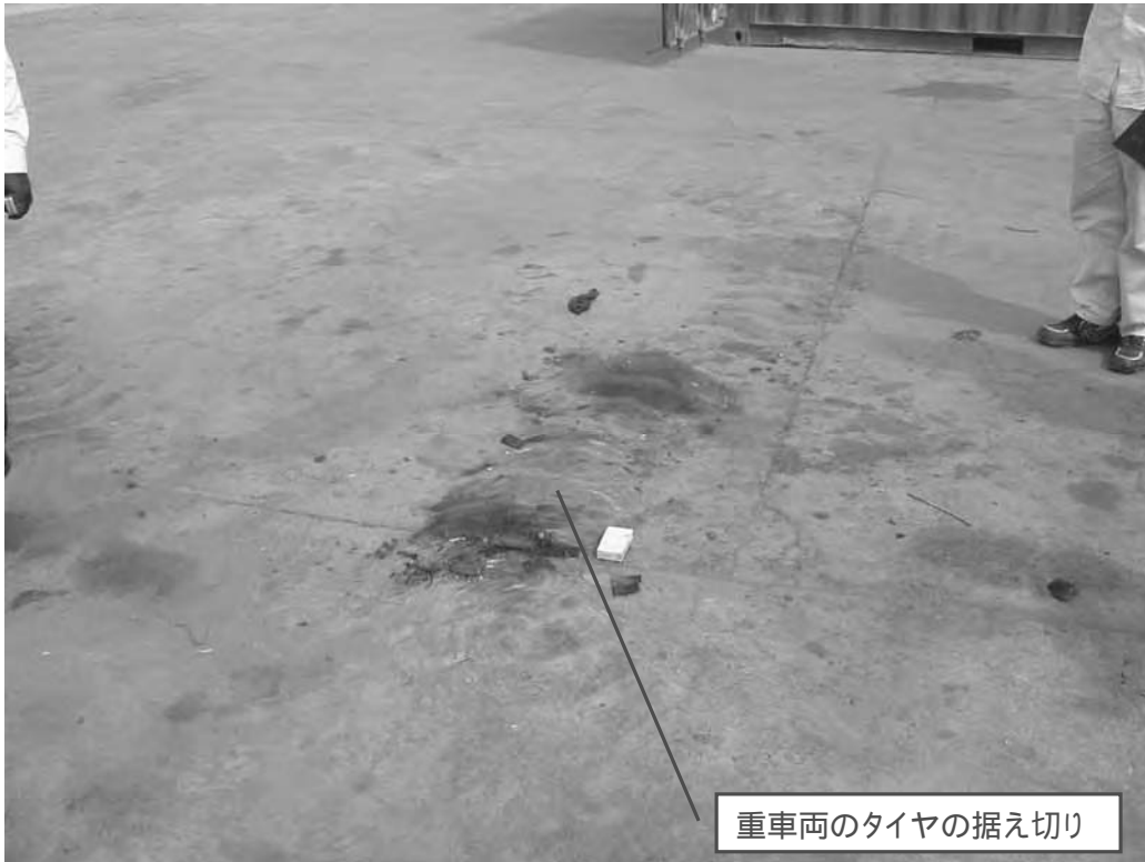
写真 - N5 ヤードの舗装部分
