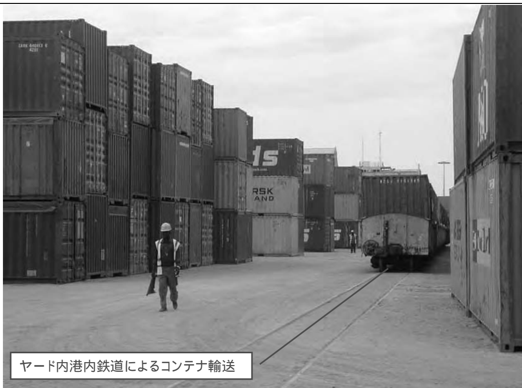
写真 - L8 ロビト港 No.8 岸壁背後のヤード
