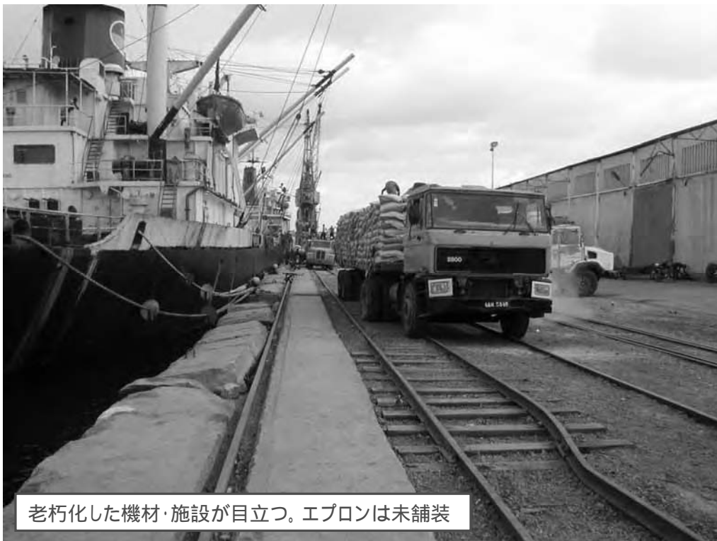
写真 - N6 No.3A 岸壁での荷役状況
